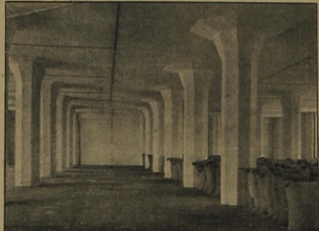
Abb. 20 u. 21. Innenraum des Speichers mit trägerlosen Pilzdecken
