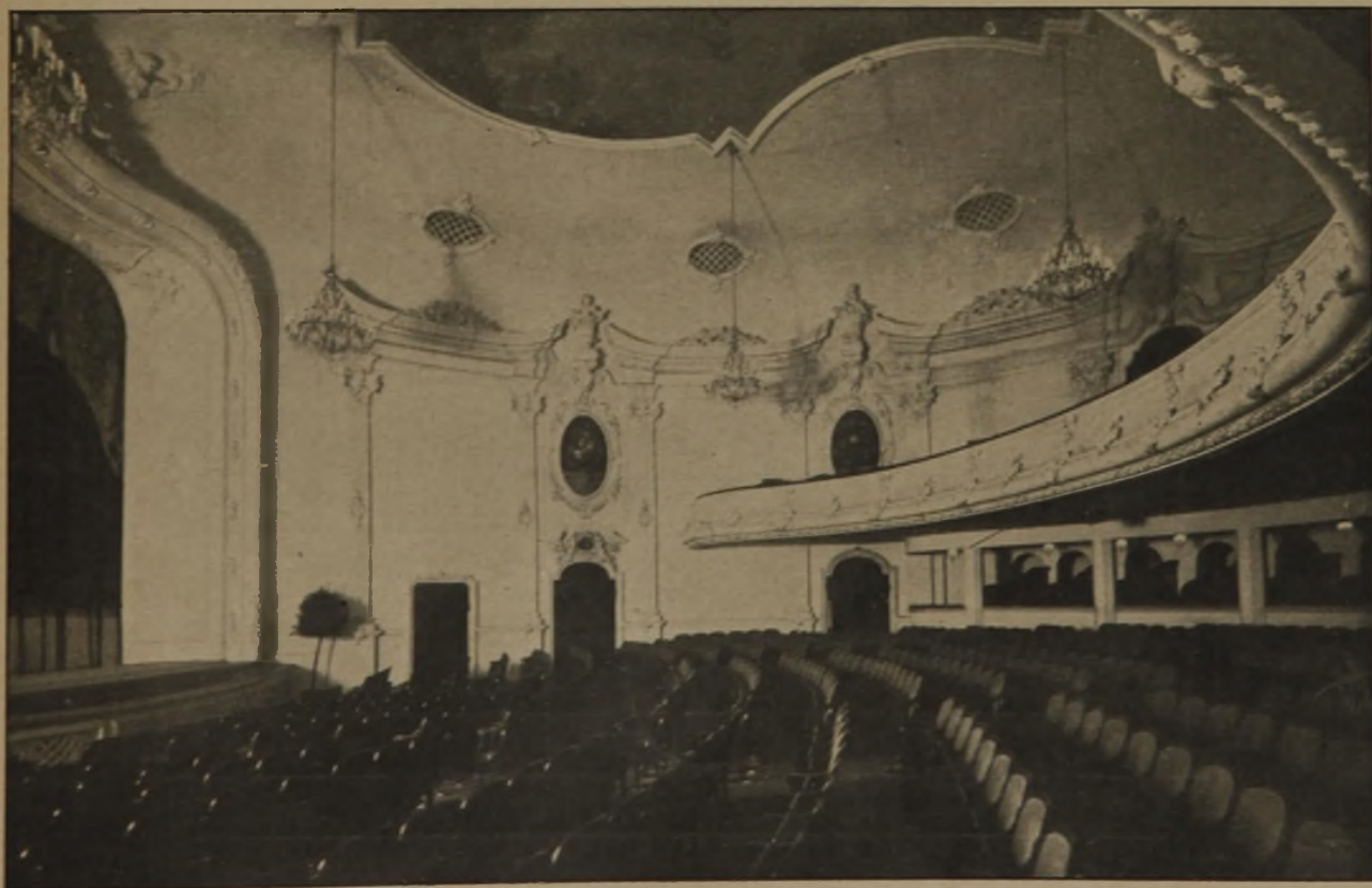
Abb. 1. Zuschauerraum des Kinotheaters in Riga.
