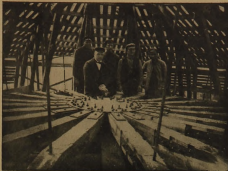
Abb. 6. Zusammenführung der Obergurte.
