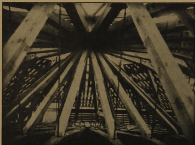
Abb. 7. Zusammenführung der Untergurte.
