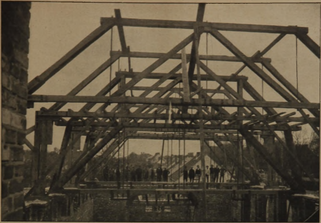
Abb. 14. Zweietagenbinder mit je 3 eisernen Schuhen für die Unterzüge.
