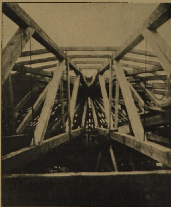
Abb. 8—10. Einzelheiten der Kuppel-Konstruktion.
