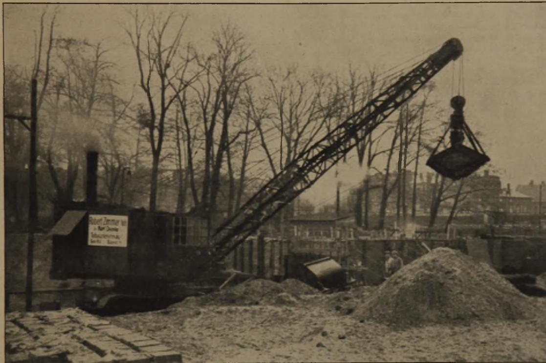
Abb. 1. Raupenbagger als Greifbagger bei der Arbeit.
