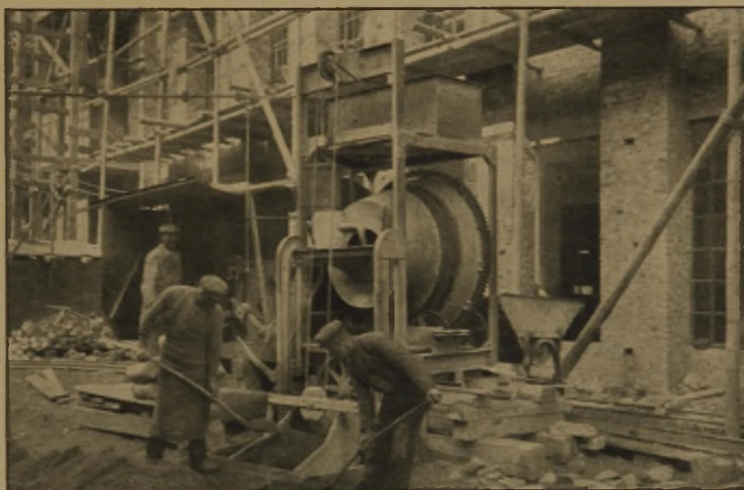
Abb. 2. Desgleichen mit lotrechter Beschickung. 300 l, 10 PS.
