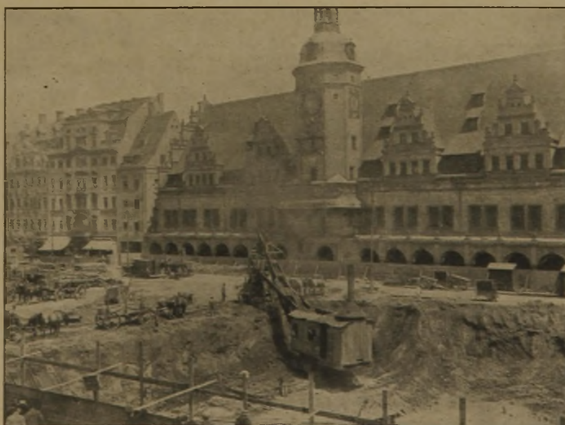
Abb. 3. Löffelbagger der Firma Orenstein & Koppel, Berlin. Beim Aushub für das Untergrundmessehaus am Marktplatz zu Leipzig.
