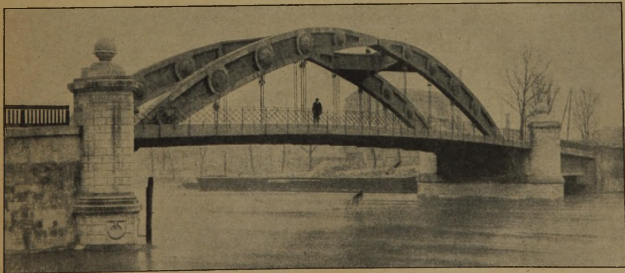
Abb. 1. Hauptöffnung der Brücke mit Dreigelenk-Eisenbetonbogen von 47,6 m Stützweite.
