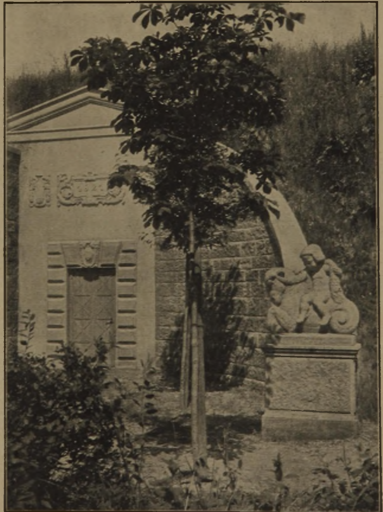
Abb. 1. Eingang zur Schieberkammer.
