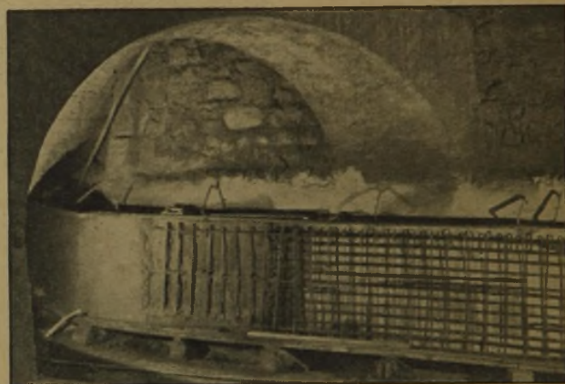
Abb. 3. Eisenbeton-Ringanker im Dachgeschoß des Westturmes.
