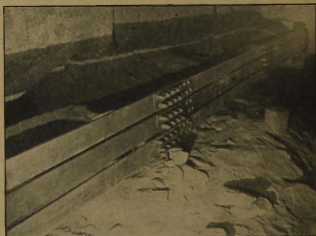
Abb. 3. Eisenbeton-Ringanker im Dachgeschoß des Westturmes.
