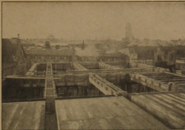
Abb. 6. Hohlsteindecke während der Herstellung.
