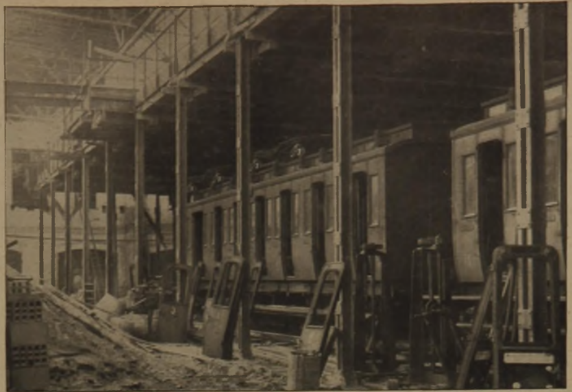
Abb. 13. Aufhängung der Schalung an die Trägerflansche.
