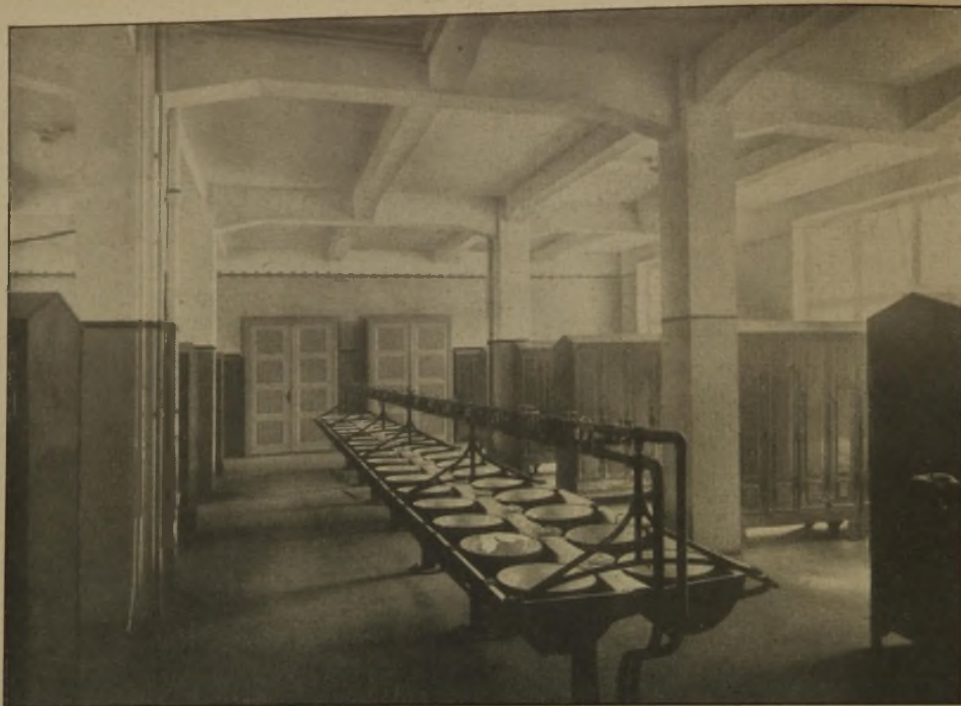
Abb. 10. Blick in die Wasch- und Umkleide-Räume im Erdgeschoß.
