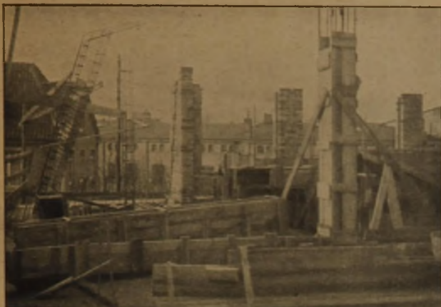
Abb. 5. Ausführung des Mansard-Geschosses.
