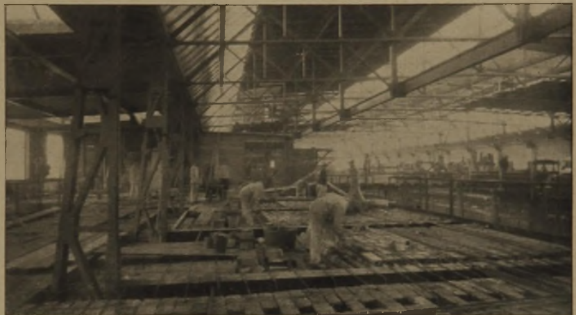
Abb. 14. Aufsicht auf die Berrer-Decke in der Ausführung.
