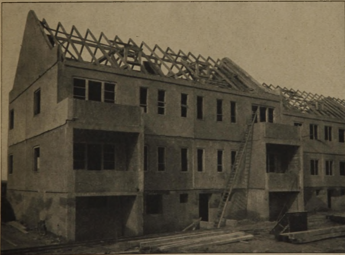
Abb. 4. Fertig zusammengesetztes Haus bei Aufstellung des hölzernen Dachstuhls. Die ersten Wohnungsbauten aus Betonplatten in Deutschland.
