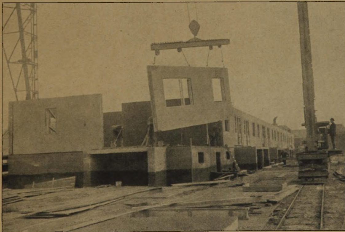
Abb. 2. Versetzen der Betonplatte mit Hilfe des Krans Abb. 1.
