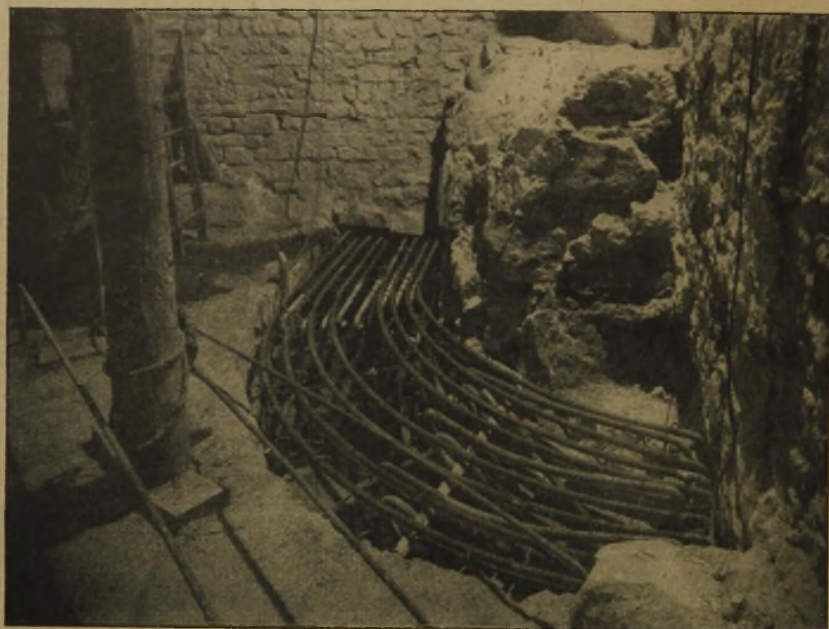
Abb. 9. Bewehrung des Ringfundamentes.
