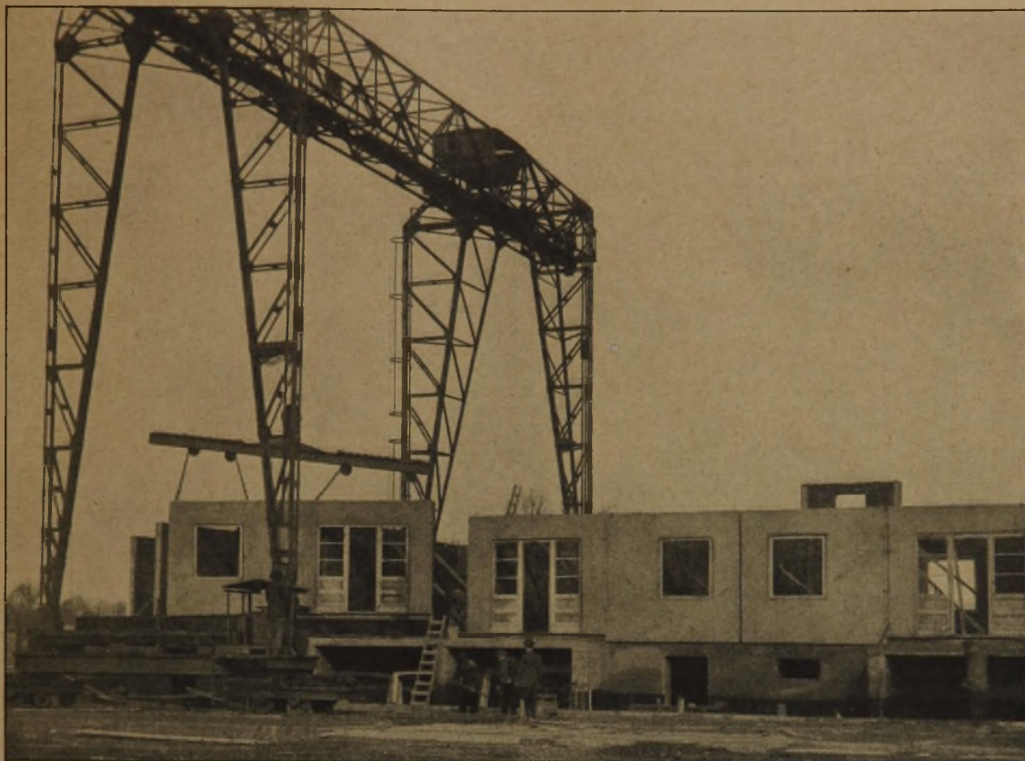
Abb. 1. Kran zum Versetzen der Betonplatten-Wände.
