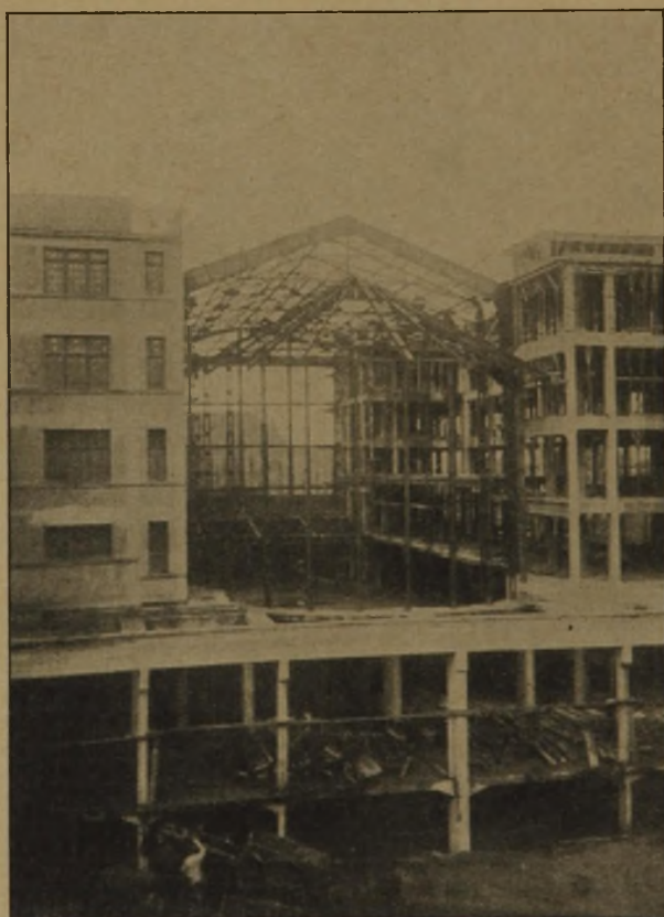
Abb. 5. Montage des Rundbaus über Sängerempore.
