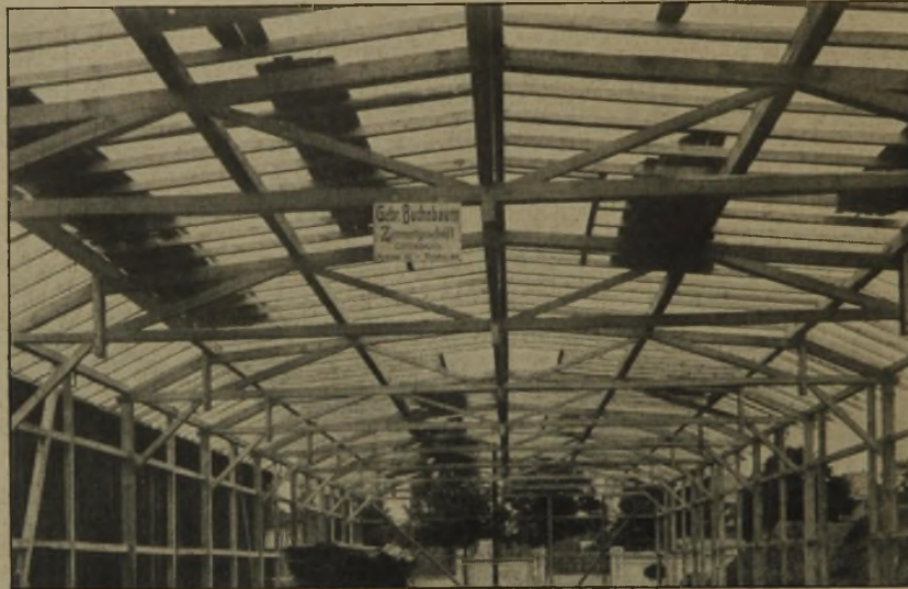
Abb. 7. Halle des Elektrizitäts-Werkes Offenbach a. M. System Heßler.
