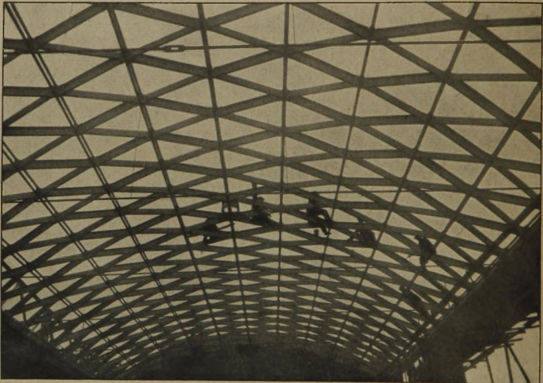
Abb. 3. Montage einer Tragkonstruktion eines gebogenen Junkers-Daches.
