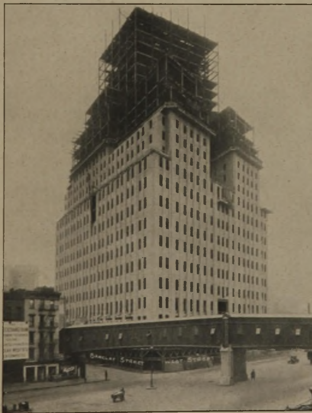
Abb. 24. Wie Abb. 22 u. 23. Bauzustand am 31. 3. 25.
