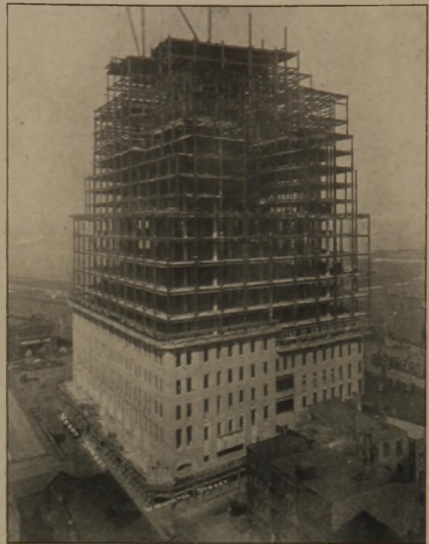
Abb. 23. Desgl. und Einbau der Decken und Außenwände. Bauzustand am 28. 2. 25.
