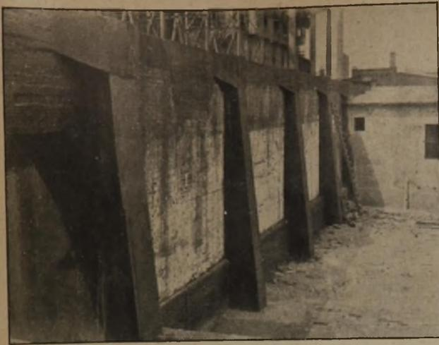
Abb. 1. Verstärkung einer Ziegelmauer mit Eisenbeton-
