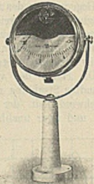
Abbildung 9. Milliampereometer zur Messung der Intensität der Strahlung.
