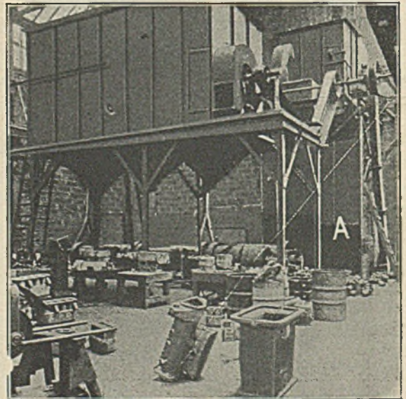
Abbildung 18. Blick in die Gußputzerei.
