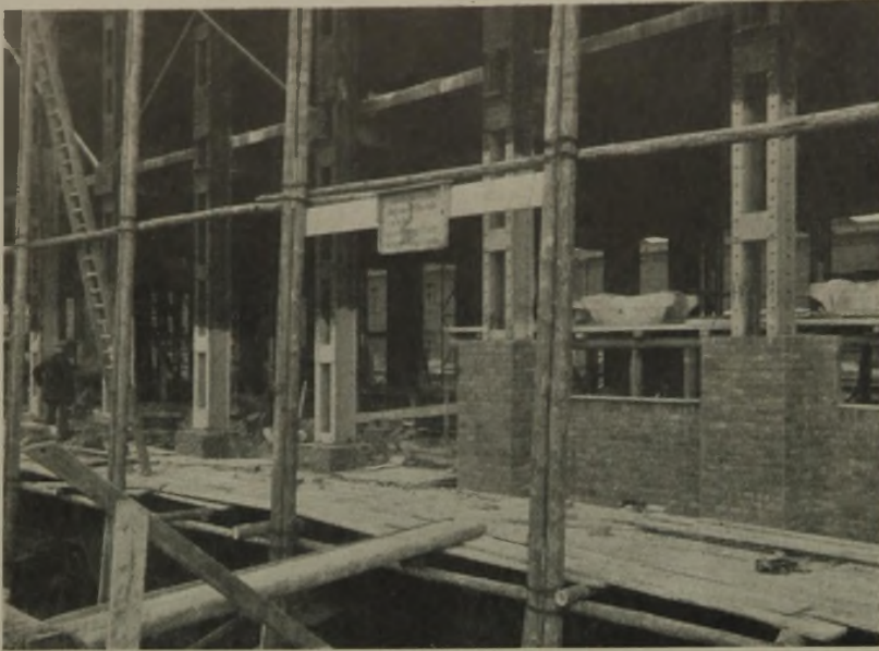
ABB. 10 UMMAUERUNG DER AUSSENSTÜTZEN IM ERDGESCHOSS
