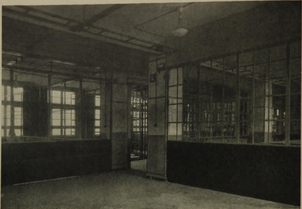
ABTRENNUNG DER BETRIEBSBÜROS DURCH EISERNE GLASWÄNDE AUS NORMALTEILEN
