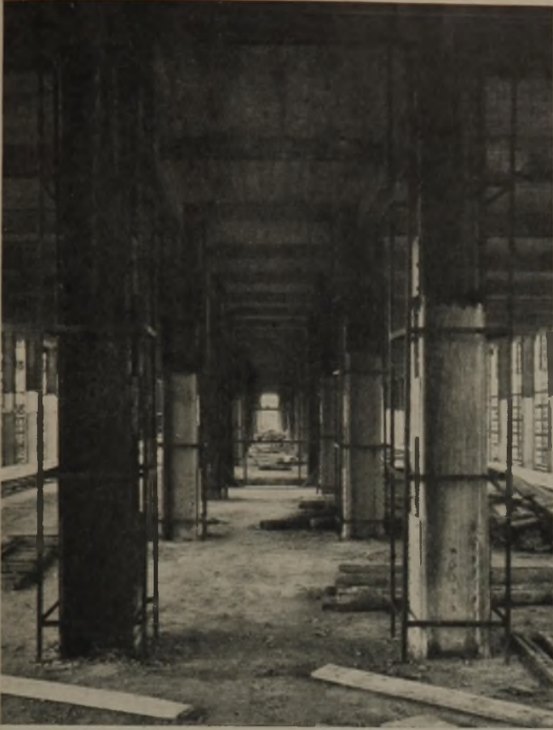
ABB. 12. UMMANTELUNG DER INNENSTÜTZEN
