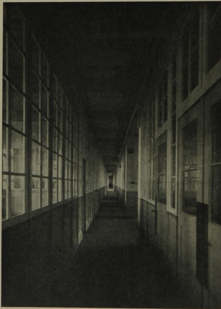
ABTRENNUNG DER BETRIEBSBÜROS DURCH EISERNE GLASWÄNDE AUS NORMALTEILEN
