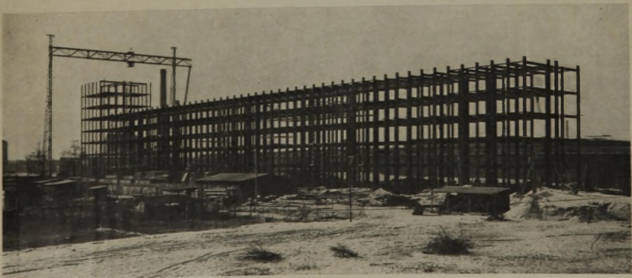
GESAMTANSICHT DER BAUSTELLE AM 16. 2. 27 (Das Stahlskelett wird mit 42 m hohem Portalkran aufgestellt, der sich grade am Südende des Baues befindet, wo die Konstruktionsteile gelagert sind)
