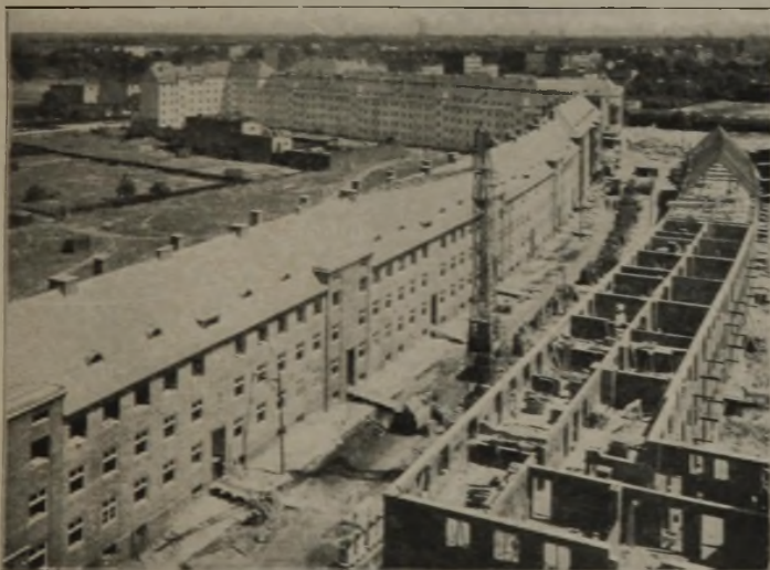
ABB. 4 u. 5. AUFFÜHRUNG VON SIEDLUNGSBAUTEN OHNE GERÜST MITTELS TURMKRAN
