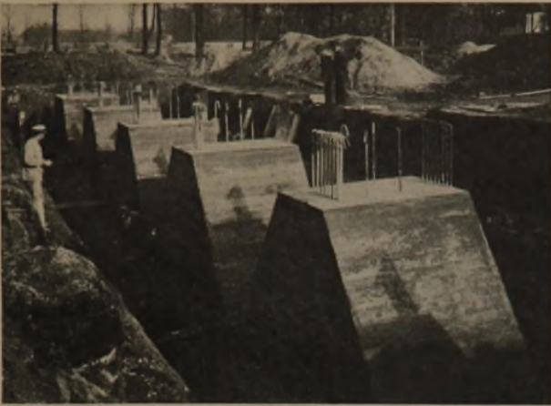
ABB. 4. BETONFUNDAMENTE DER HAUPTPFELER
