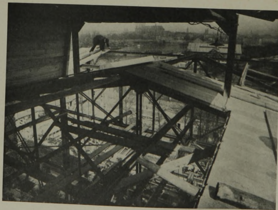
EINDECKEN DES SAALDACHES MIT BIMSBETON- PLATTEN
