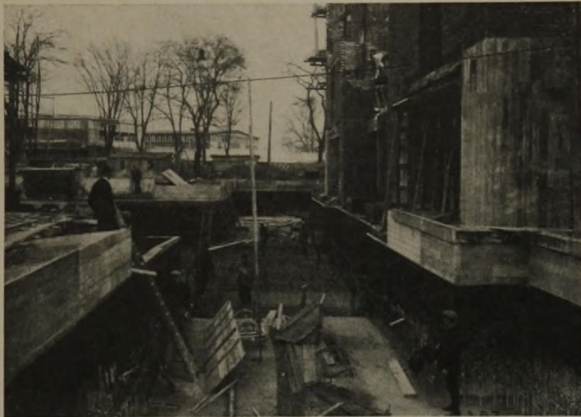
BETONIEREN DES UNTER GRUND- WASSER LIEGEN- DEN KELLERS
