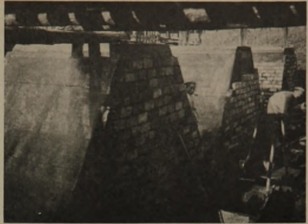
ISOLIERUNG UND UMMAUERUNG ABB. 5 DER FUNDAMENTBLÖCKE
