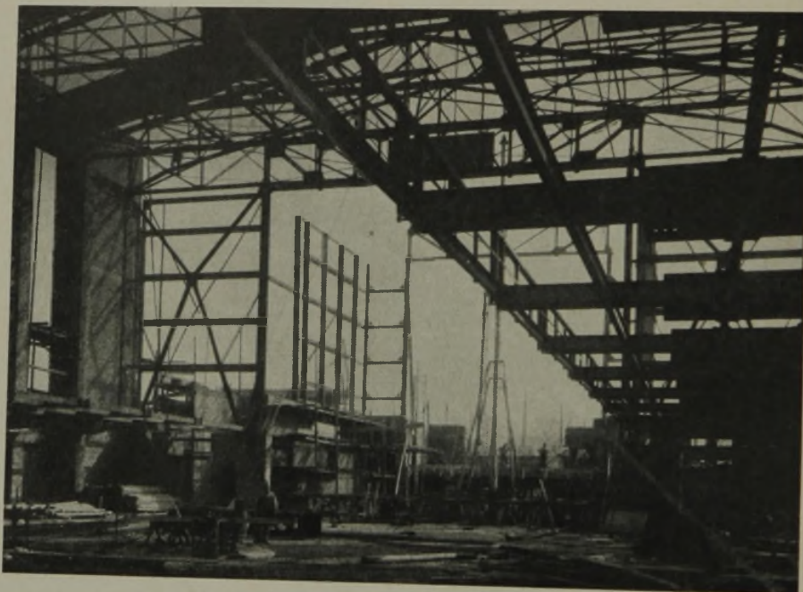
RECHTS EISEN- GERIPPE DER EMPOREN
