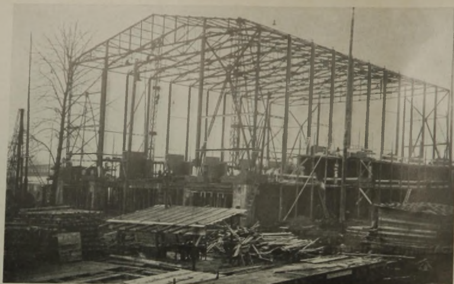
EISENGERIPPE DES HAUPTSAALES (Stützweite 32 m)
