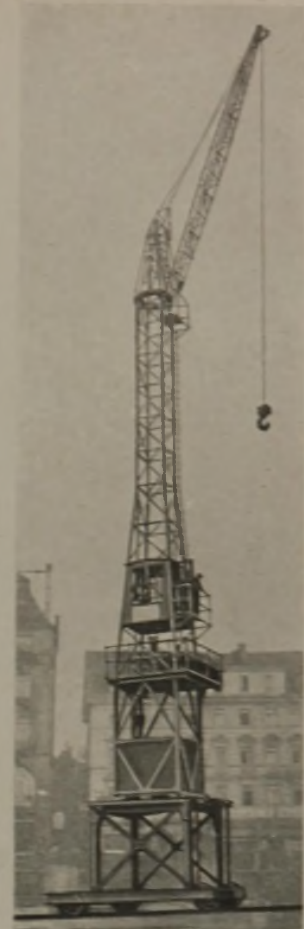
ABB. 2 (RECHTS) FERTIG AUFGESTELLTER TURMKRAN
