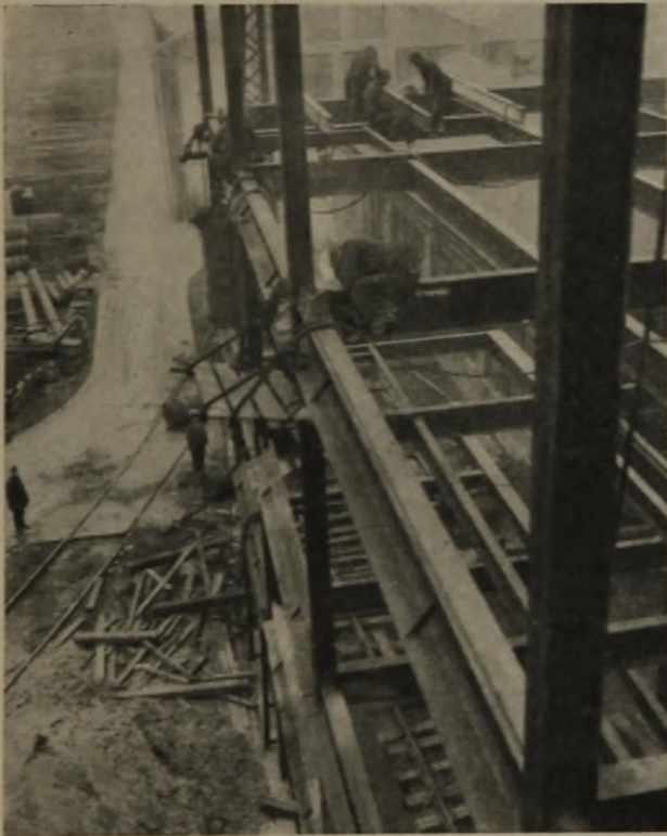
ABB. 5. STAHLSCHELETT DES FÜNF STOCK HOHEN GESCHWEISSTEN WESTINGHOUSE-GEBÄUDES IN SHARON U. S. A.
