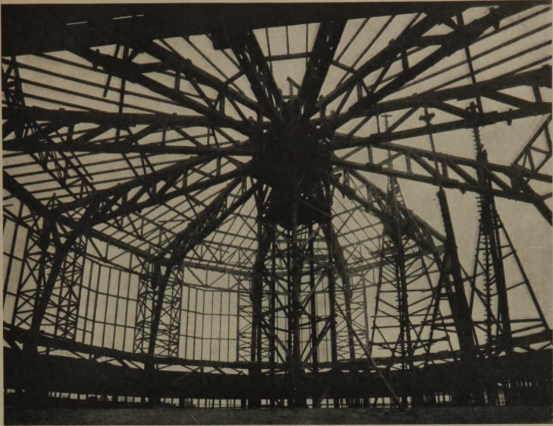
HOLZBINDER DER KUPPELHALLE VON 66 m Dm.
