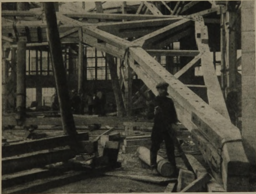
AUFRICHTUNG EINES ABGEBUNDENEN BINDERS (EINZELHEITEN DER KNOTENPUNKTE) (Ausführung Tuchscherer A.-G., Breslau)
