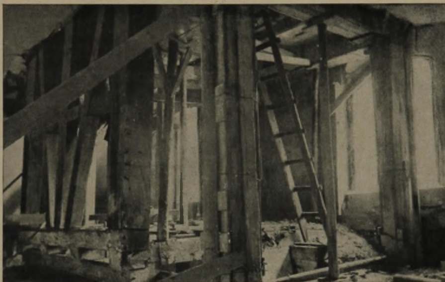
ABB. 14 (RECHTS) AUSFÜHRUNG DES NEUEN EISEN- BETON-DACHANKERS ZWISCHEN DEM ALTEN HOLZWERK
