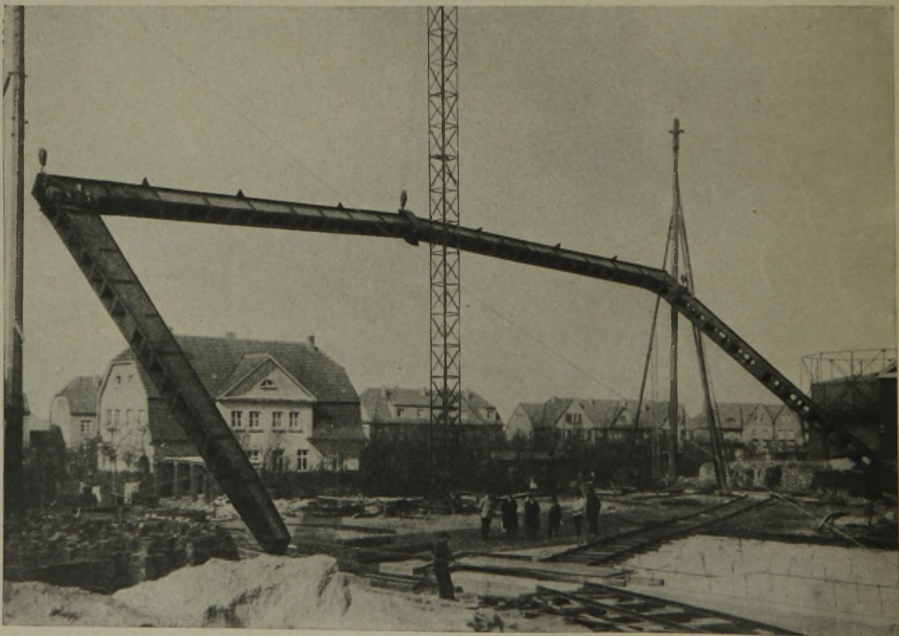
BERGBAU-A. G. „LOTHRINGEN“, SCHACHT IV IN GERTHE I. W. Aufstellung eines Rahmenbinders des Kesselhauses von 42 m Stützweite, 25 m Firsthöhe und 40000 kg Gewicht
