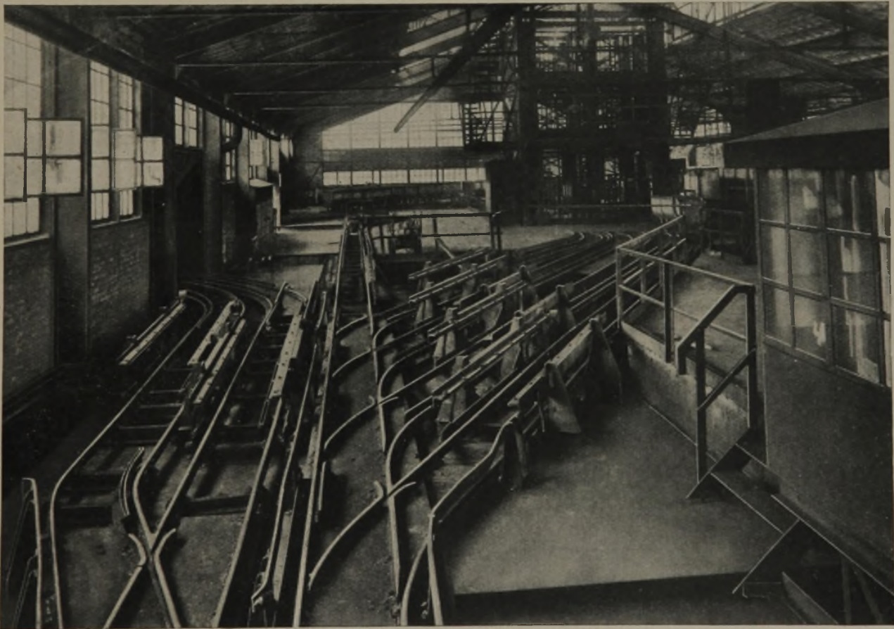
RHEINISCHE STAHLWERKE, ZECHEN CENTRUM, SCHACHT I/III, WATTENSCHIED Schachtausläufe, Schachttumführung und Zentralpunkt mit 7 Bremsen des automatischen Wagenlaufes
