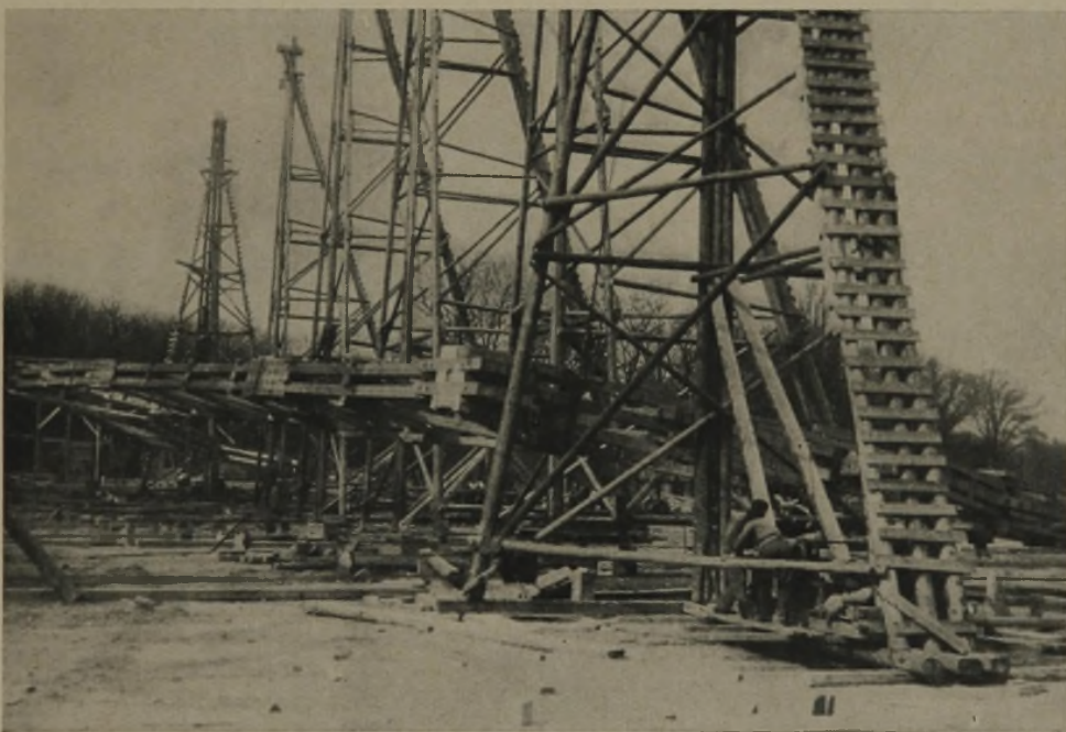
AUFRICHTUNG EINES RAHMENBINDERS
