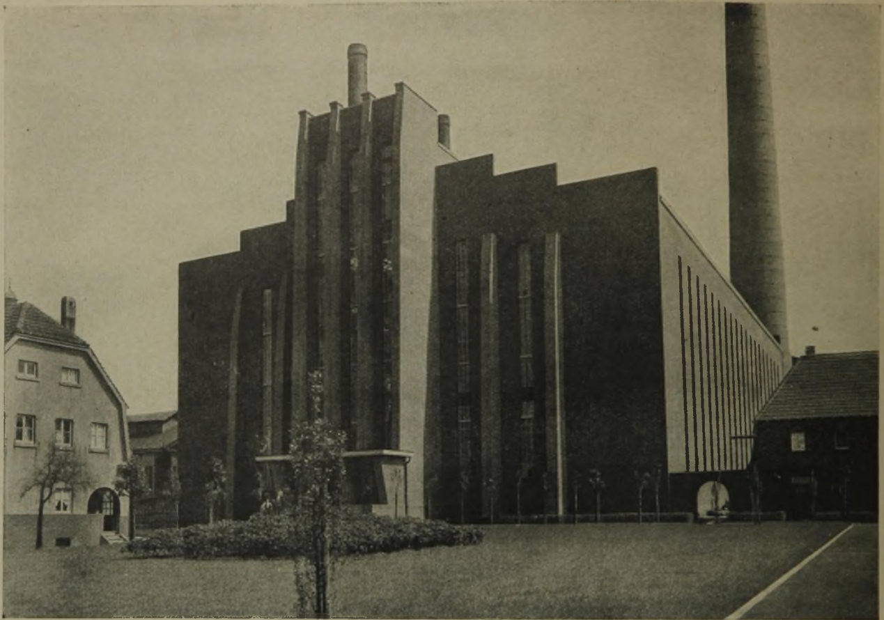
BERGBAU-A. G. „LOTHRINGEN“, SCHACHT IV IN GERTHE I. W. Ansicht der vorderen Giebelwand des Kesselhauses
