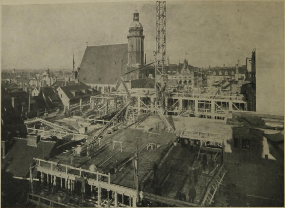
AUFNAHME DER BAUSTELLE AM 24. 11. 28. HERSTELLUNG DER DECKEN IN GUSSBETON
