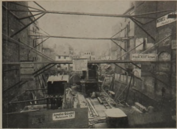
ZUSTAND DES BAUPLATZES AM 14. 1. 28. ABB. 6
