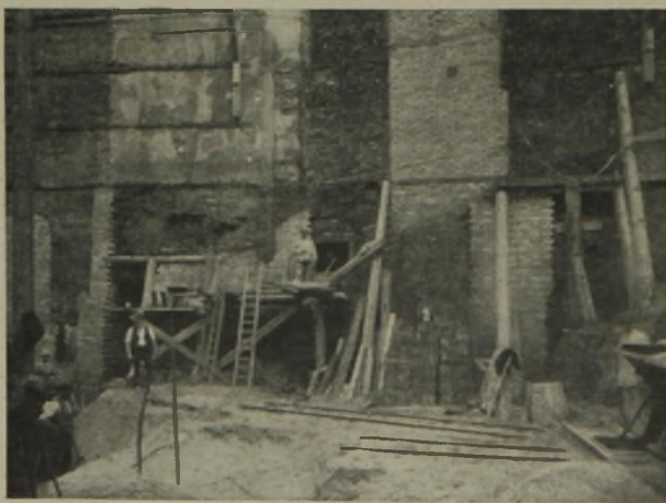
ABB. 10. ABSTÜTZUNG UND UNTERFAHRUNG DER UMFASSUNGSMAUERN DER NACHBARGRUNDSTÜCKE
