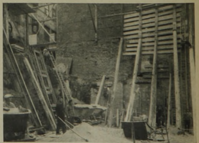
ABB. 10. ABSTÜTZUNG UND UNTERFAHRUNG DER UMFASSUNGSMAUERN DER NACHBARGRUNDSTÜCKE
