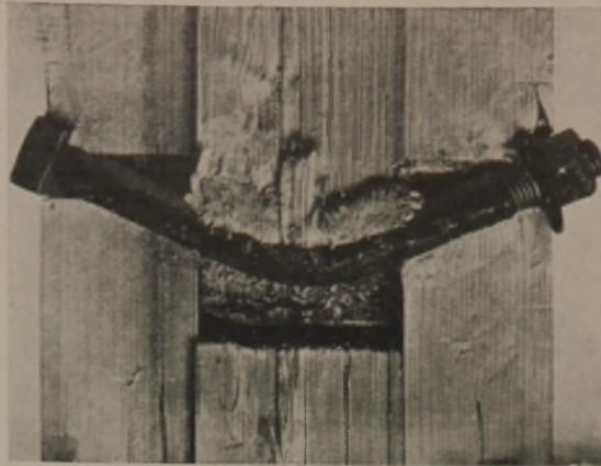
BOLZENVERBINDUNG. ABB. 2 Formänderung nach erfolgter Prüfung Versuch Staatl. Mat.-Prüfungsamt Stuttgart
