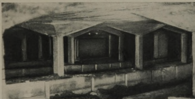
ABB. 3 (LINKS) BLICK UNTER DIE PILZDECKE
