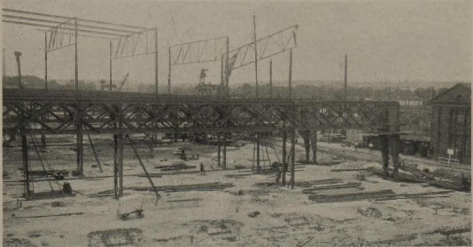
ABB. 2 AUFLEGEN DER DACH- BINDER
