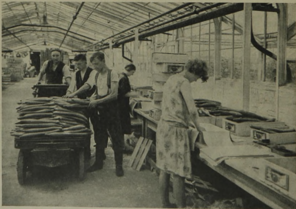
VERPACKUNGSRAUM AM ANFANG DES VERBINDUNGSGANGES Gewächshausanlage am Großkraftwerk Klingenberg in Berlin-Lichtenberg
