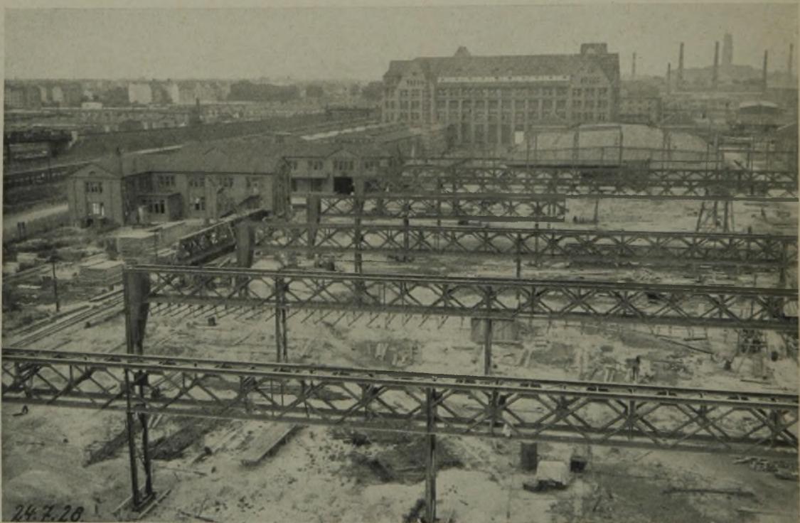
GESAMTBILD DER BAUSTELLE. AUFSTELLUNG DER KRANBAHNEN
