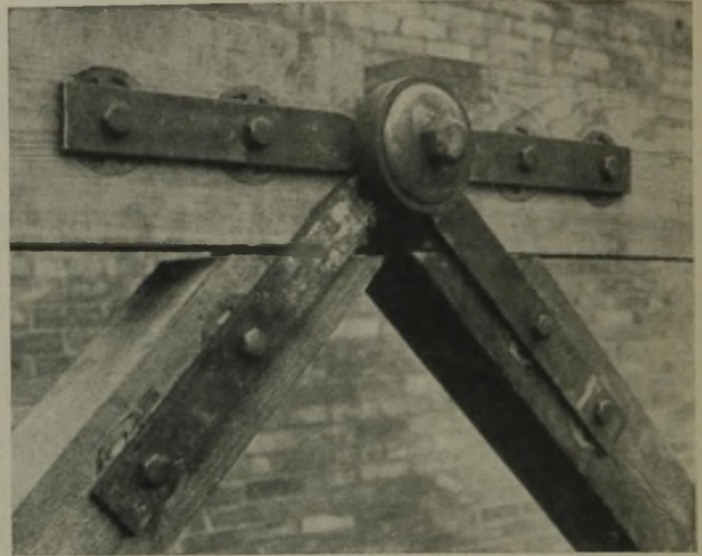
STAHLGELENK EINES VERSUCHSTRÄGERS. ABB. 5a
