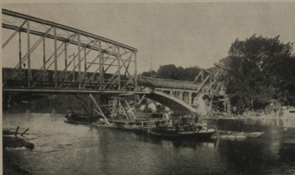
WÄHREND DES AUSFAHRENS DER ALTEN CRÖLLWITZER BRÜCKE
