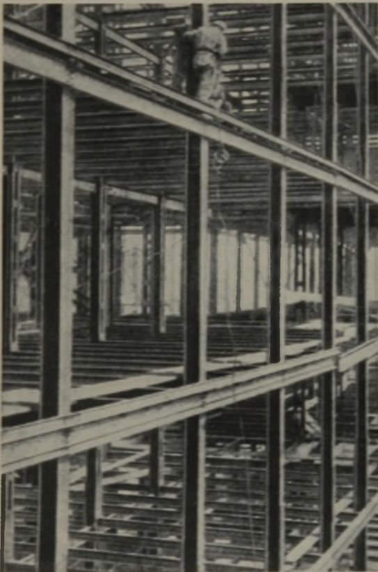
FERTIGES STAHLSCHELETT
