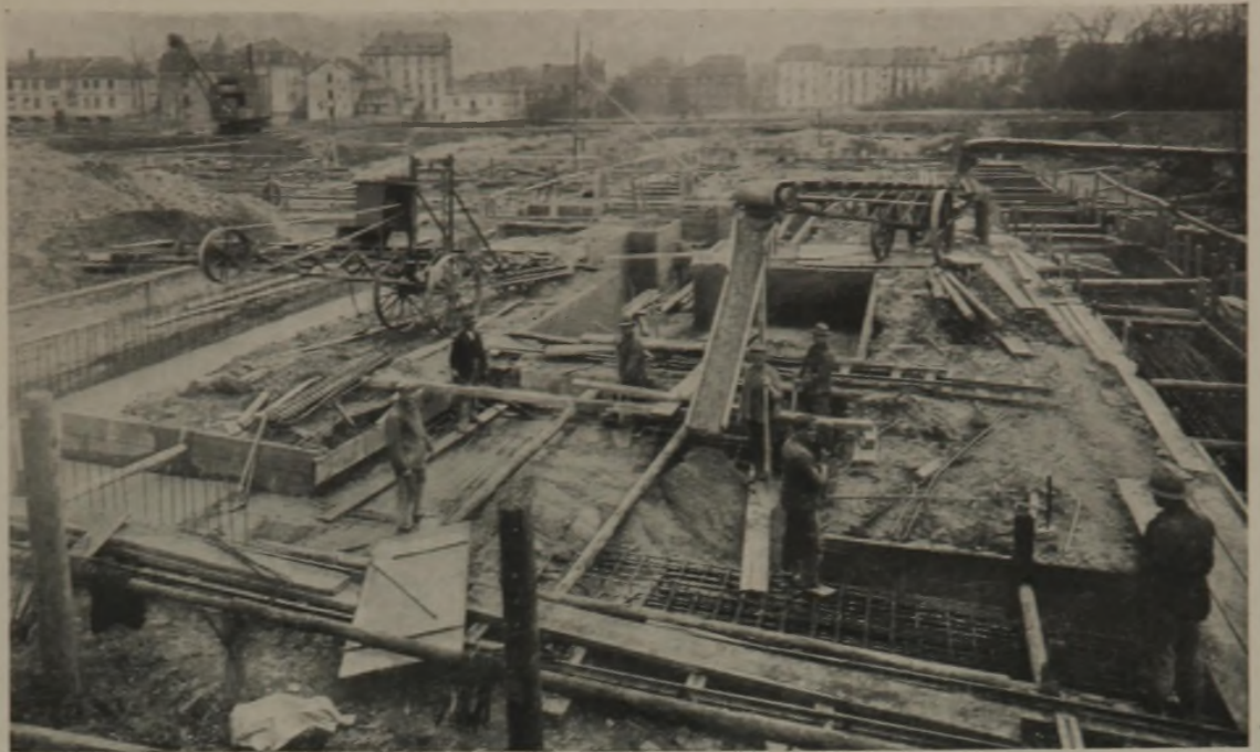
BETONIEREN DER FUNDAMENTE MIT HILFE VON FÖRDERBÄNDERN
