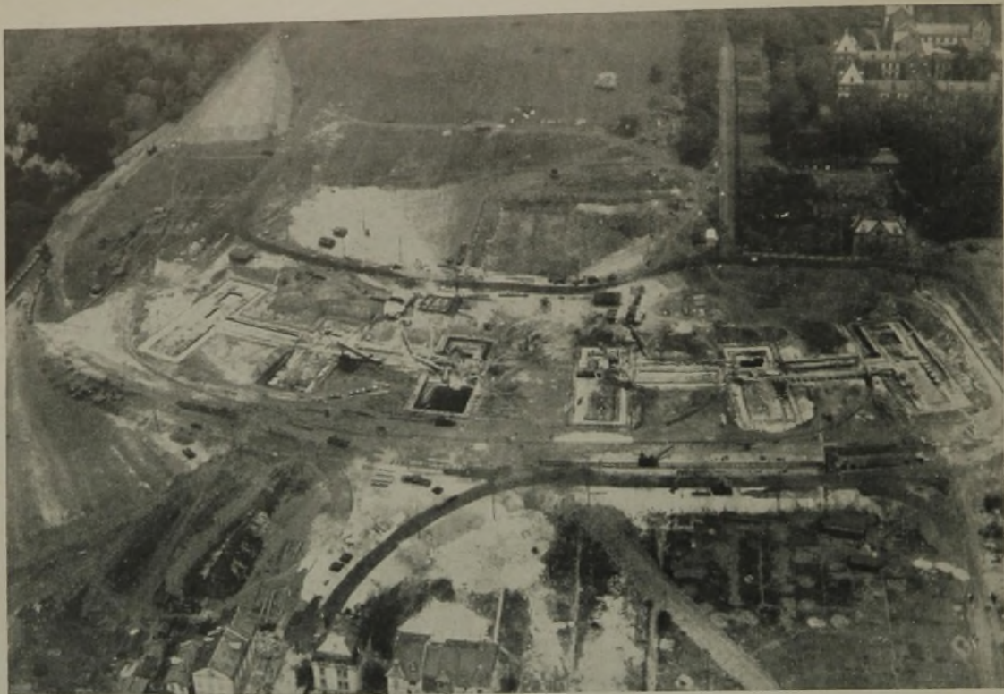
FLUGBILD DER BAUSTELLE AM 15. MAI 1929 BAUSTELLENEINRICHTUNG, STREIFEN- UND EINZELFUNDAMENTE
