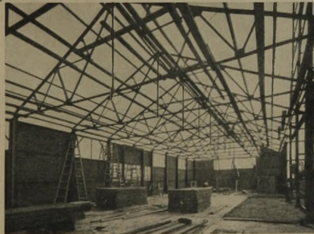
EISENHALLE MIT SOLOMIT-WÄNDEN UND BEDACHUNG
