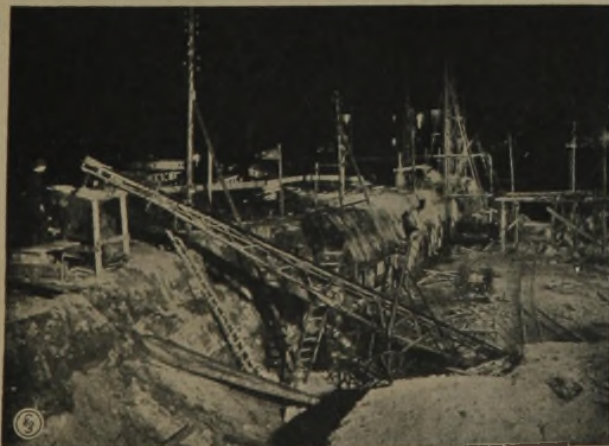
BELEUCHTUNG EINER BAUSTELLE DURCH FLUTLICHT-SCHENWERFER DER FORM 5 9 (RECHTS). FLUTLICHTLEUCHE ZU 8
