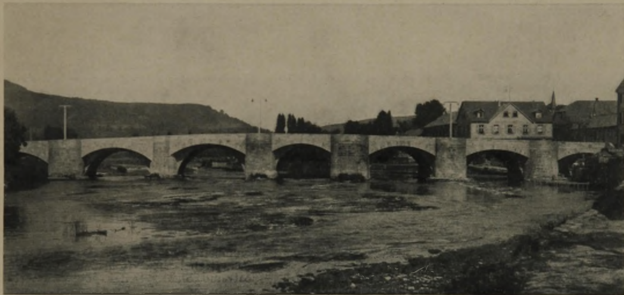
GESAMTBILD DER BRÜCKE NACH DER WIEDERHERSTELLUNG
