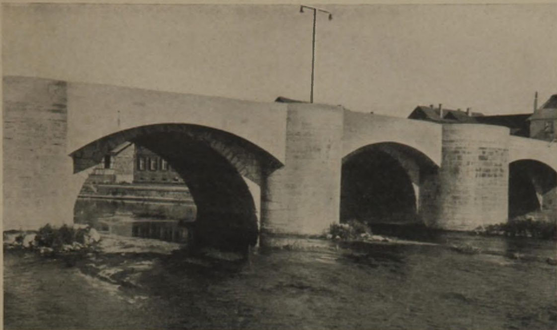
TEILBILD DER FERTIGEN BRÜCKE NACH VERBREITERUNG STICHBÖGEN-GEWÖLBE DER VERBREITERUNG, DAHINTER DIE ALTEN HALBKREISFORMIGEN GEWÖLBE
