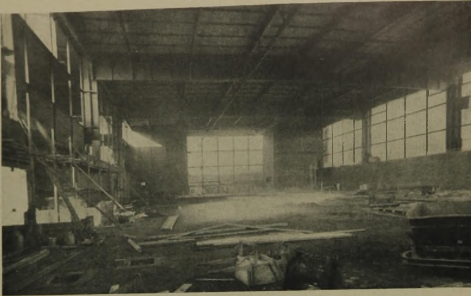
BLICK IN DIE NEUE HALLE 20 DER LEIPZIGER BAUMESSE WÄHREND DER AUSFÜHRUNG
