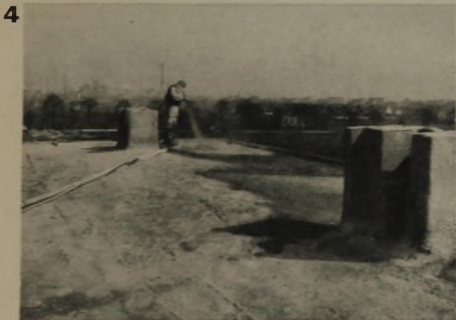
HERSTELLUNG EINES DACHES NACH DEM TORKRET-VERFAHREN
