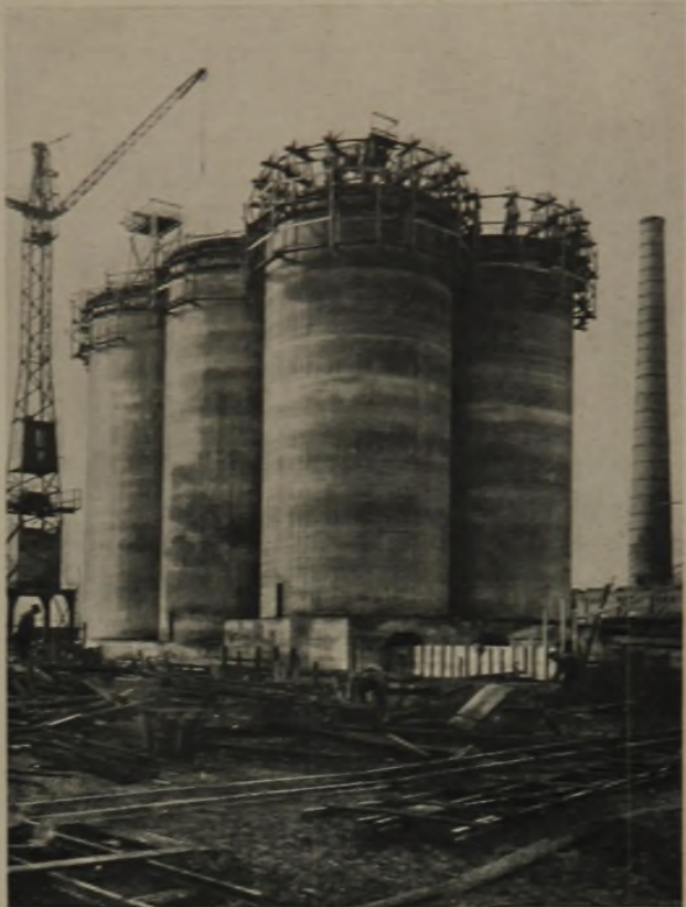
ZEMENTSILOS DER ZEMENTFABRIK NEUWIED A. RH. NACH BEENDIGUNG DER GLEITBAU-AUSFÜHRUNG DURCH DIE SIEMENS-BAUUNION, BERLIN
