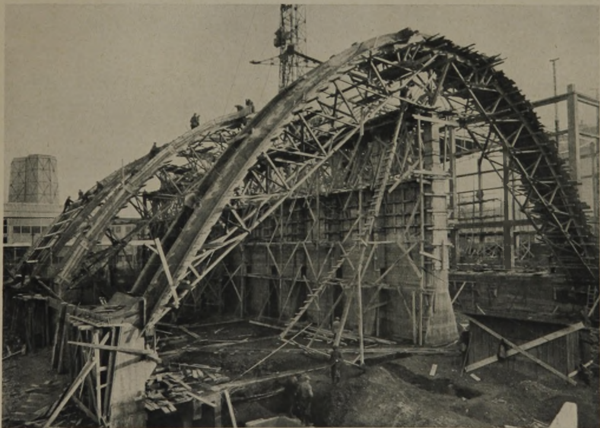
LEHRGERÜST DER BOGENBINDER (EBENFALLS DREIGELENKBOGEN)
