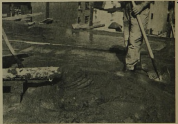
AUS DER PUMPENLEITUNG AUSFLIESSENDER BETON PATENT GIESE & HELL, KIEL
