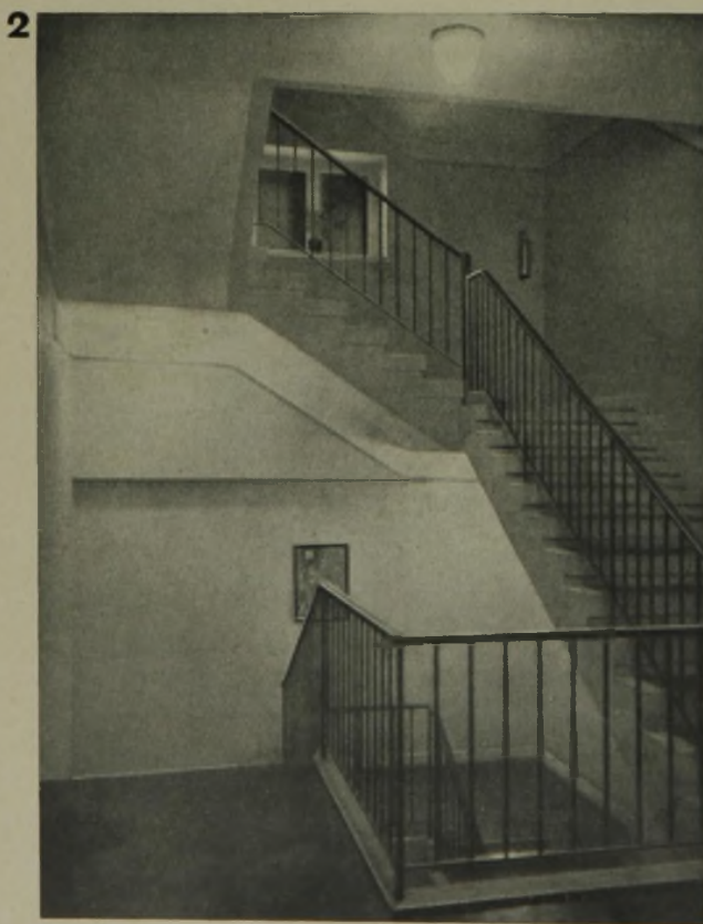
EIN ZWECKMÄSSIG BELEUCHTETES TREPPENHAUS
