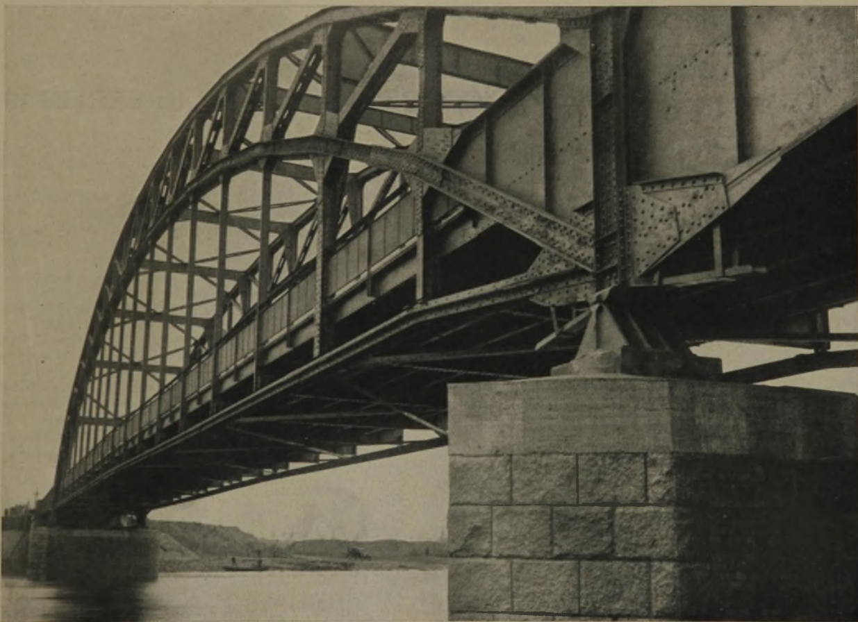
ÜBERBAU DER HAUPTSTROMÖFFNUNG MIT AUFLAGER UND ANSCHLUSS DER SEITENSPIGUNG INGENIEUR BAURAT DR.-ING. E. H. KARL BERNHARD, BERLIN
