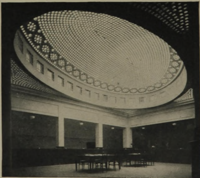
OBERLICHT IN ROTALITH-GLASEISENBETON IN EINER BANK
