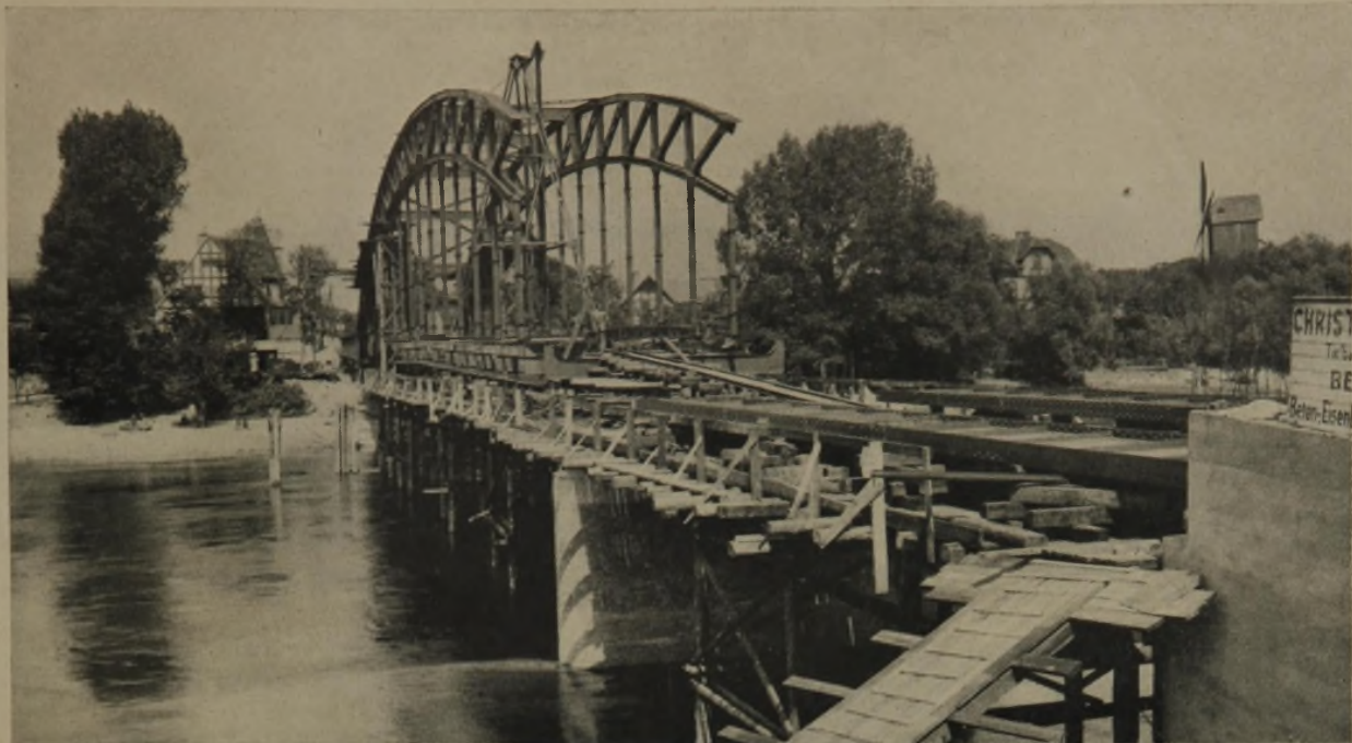
MONTAGE DER STROMÖFFNUNG DER WARTHEBRUCH-BRÜCKE
