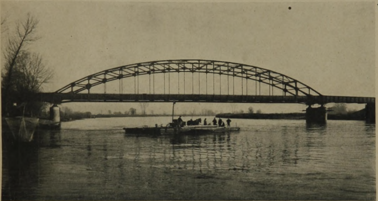
ANSICHT DER STROMÖFFNUNGEN DER WARTHEBRUCH-BRÜCKE BEI FICHTWERDER
