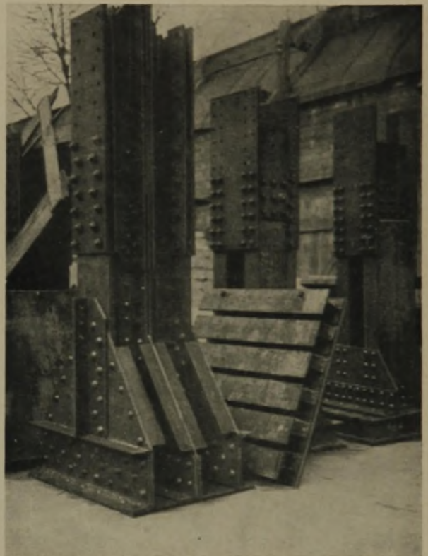
FERTIG GENIETETE STÜTZENFÜSSE
