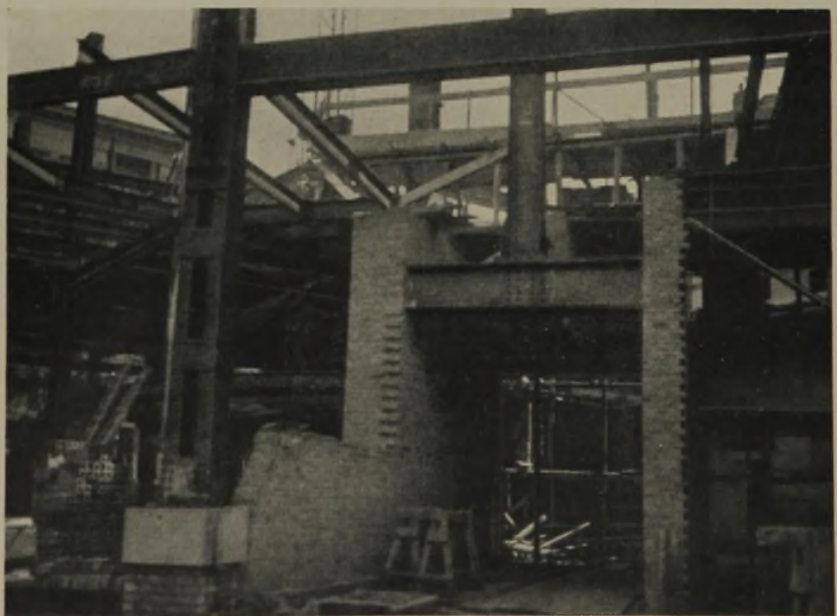
ABFANGUNG EINER STÜTZE DURCH TRÄGER ÜBER EINFAHRT 4. 6. 29
