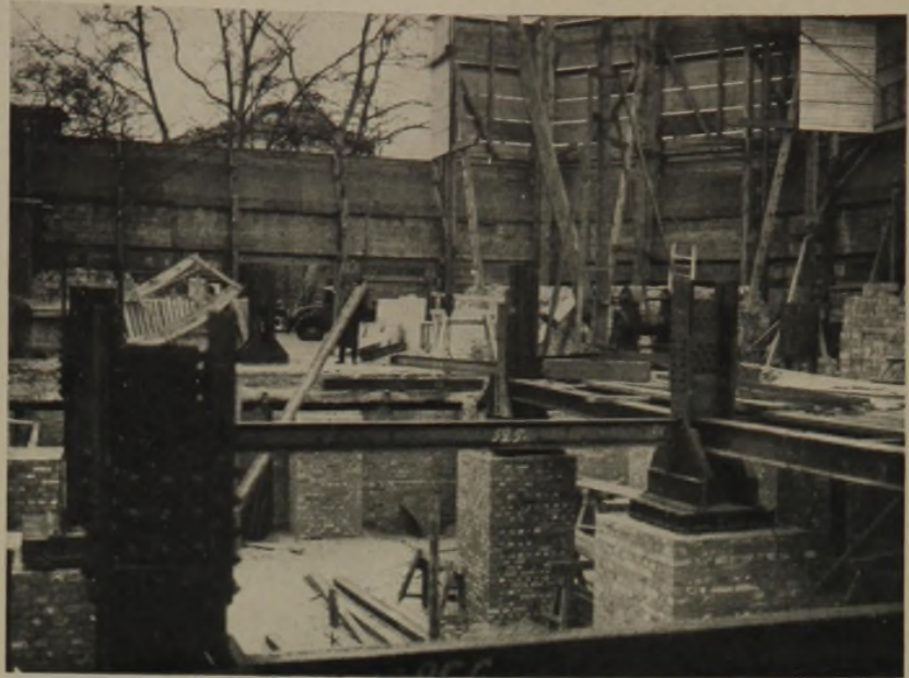
GEMAUERTE KELLERPFEILER, STÜTZENFÜSSE UND TRÄGER DER KELLERDECKE 23. 4. 29
