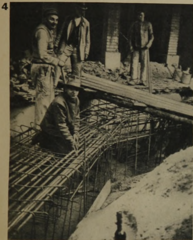
DURCHLAUF. FUNDAMENT, RUNDE FRONTECKE
