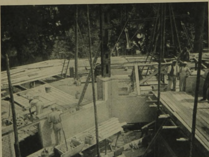
UMMAUERUNG DER EISENSTÜTZEN 19. 6. 1929
