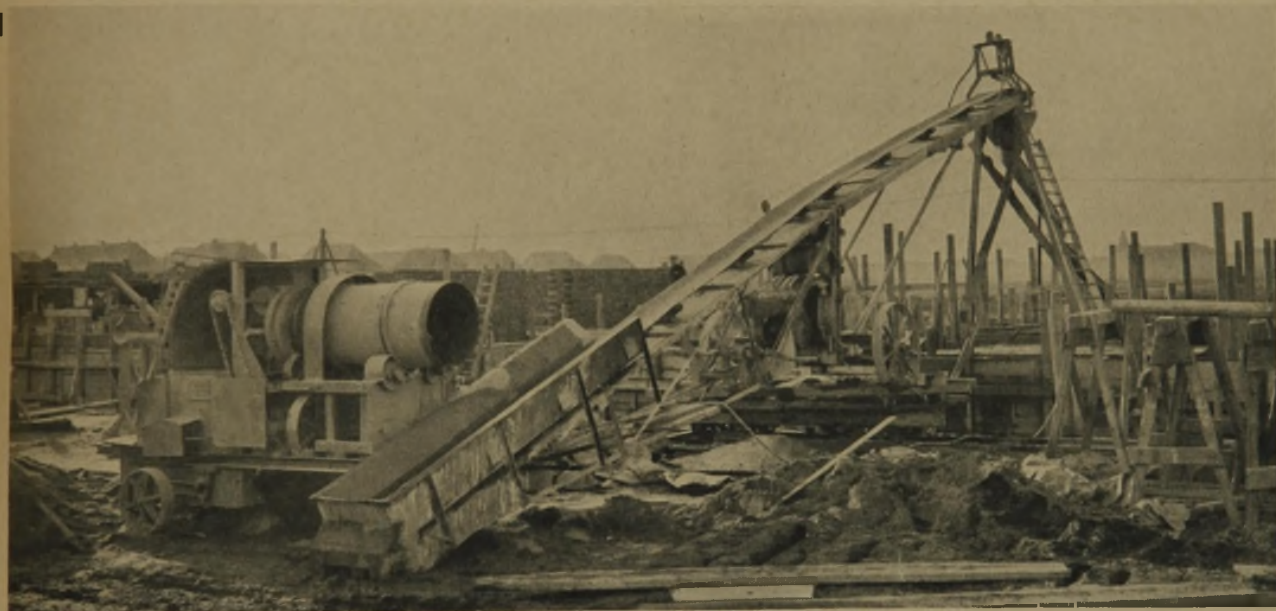
1. REGULUS-MISCHER IN FLIESSARBEIT (G. ANTON SEELEMANN & SÖHNE, NEUSTADT-ORLA. 1. MIT TRANSPORTBAND UND GIESSRINNE. 2. MIT BETONPUMPE SYSTEM GIESE & HELL, KIEL)
