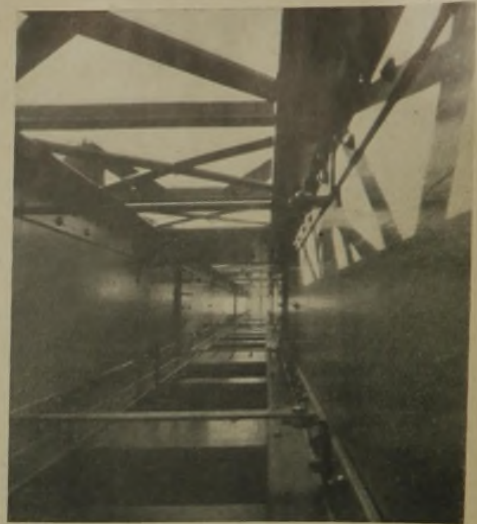
Blick in eine Stahlsäule, die Lüftung und Installationen aufnimmt
