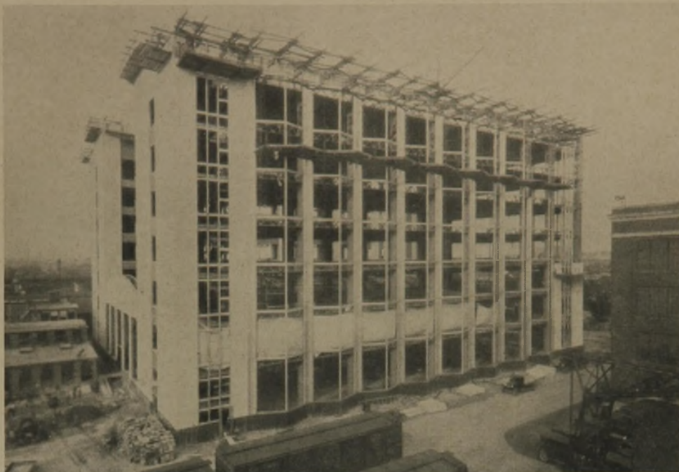
Verkleidung der Pfeiler mit Metallplatten
