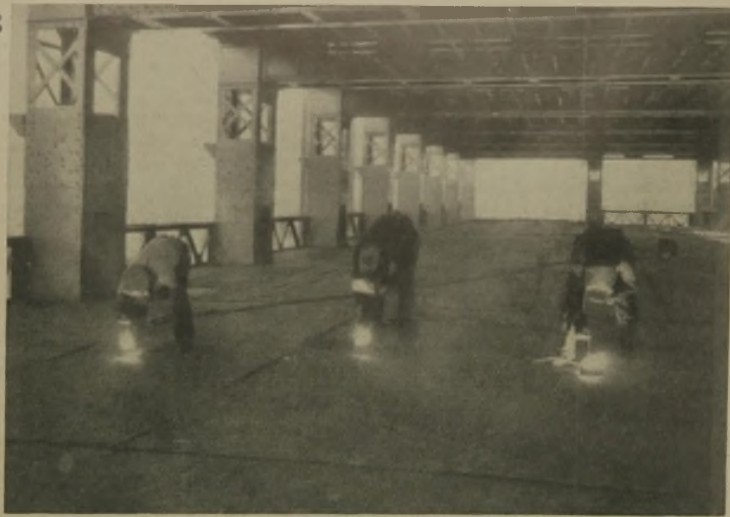
Aufschweißen der Stahlplatten der Decke
