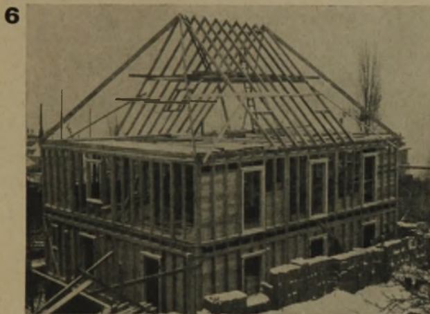
3. Tag (Aufstellen des Daches)
