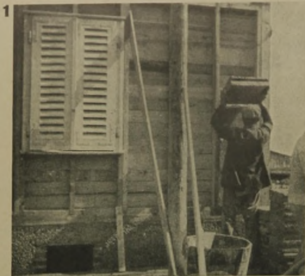
Einlegen der Platten der Außenwand
