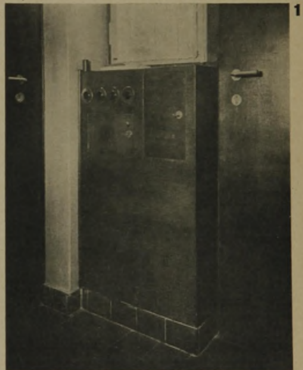
Windfang eines Einfamilienhauses. Nach Fertigstellung der Maurer-, Putzer- und Installationsarbeiten und nach Einsetzen der mit einem Fenster gekuppelten Haustür, wird eine Sperrholzverkleidung eingebaut, in der die Lichtschalter für Garten, Windfang, Toilette und Diele, ferner der von außen zugängliche Briefkasten und ein Handschuhkasten eingelassen sind und die zugleich die am meisten der Beschädigung ausgesetzten Stellen vor Abnutzung schützt.
