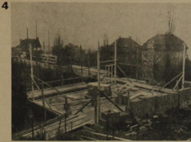
1. Tag. Beginn der Montage
