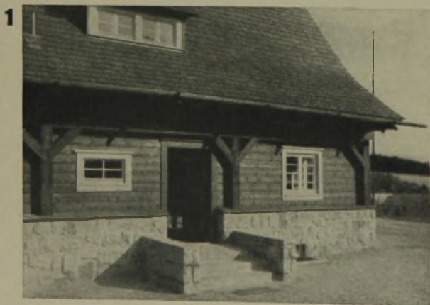
Holzhaus von Architekt Dr. Ing. Franke
