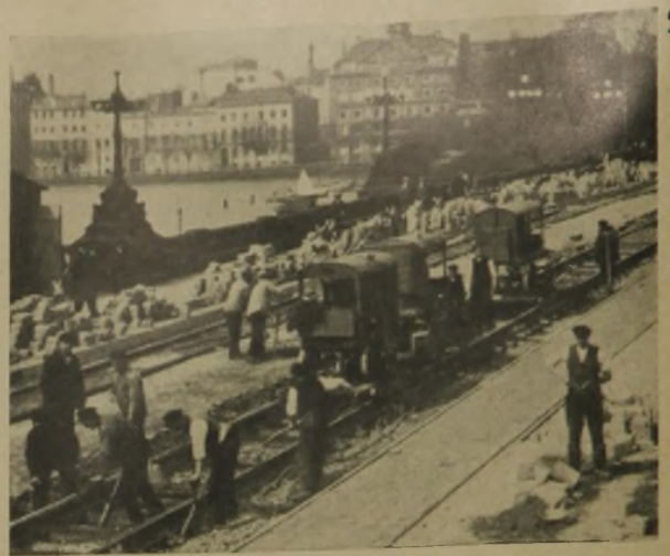
Gleisstopfung mit Prebluft-Werkzeug Frankfurter Maschinenbau A.-G., Frankfurt a. M.
