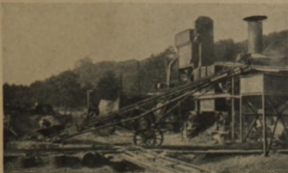
Förderband im Straßenbau Wilhelm Stöhr, Offenbach a. M.
