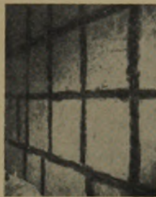
17 u. 18. Schalldämpfende Bekleidung einer Innenwand
