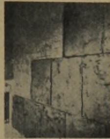
17 u. 18. Schalldämpfende Bekleidung einer Innenwand
