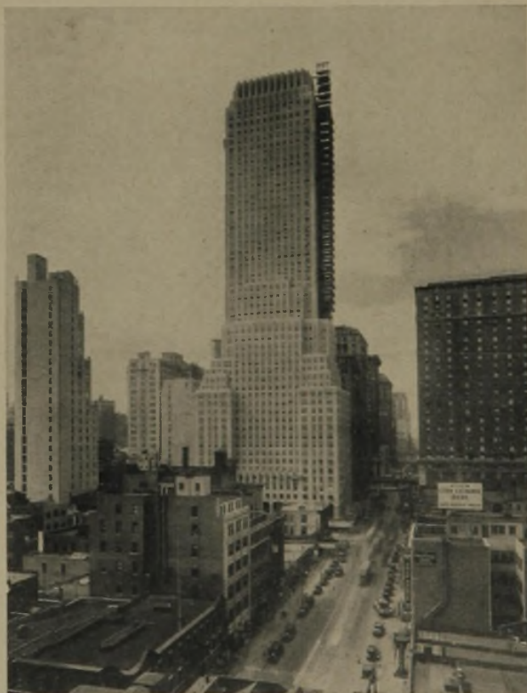
Desgl. kurz vor der Fertigstellung
