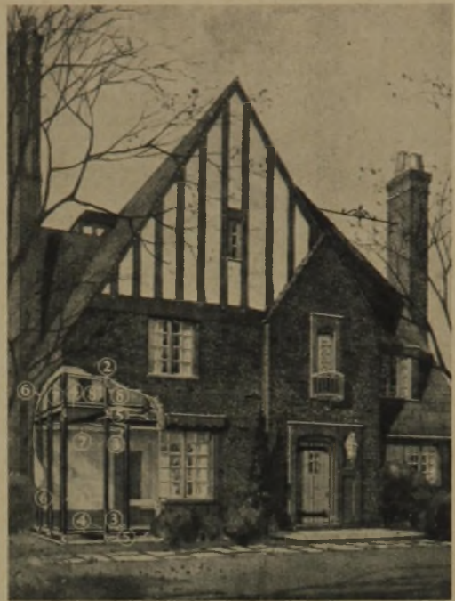
Amerikan. Stahlskelett Wohnhausbau, McKay Steel Homes and Buildings Inc. Cleveland O
