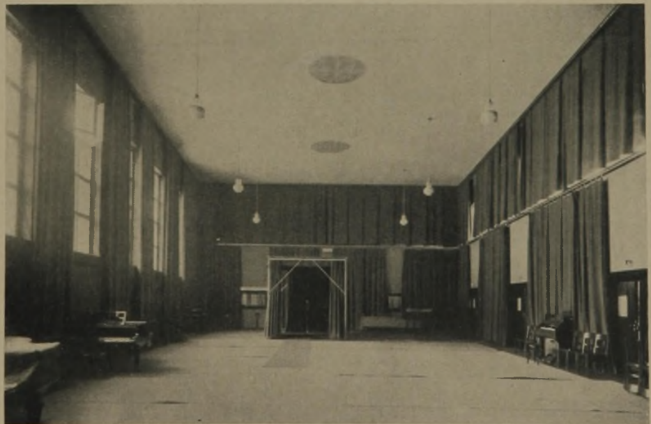
Sendesaal II mit Vorhängen für die Dämpfung
