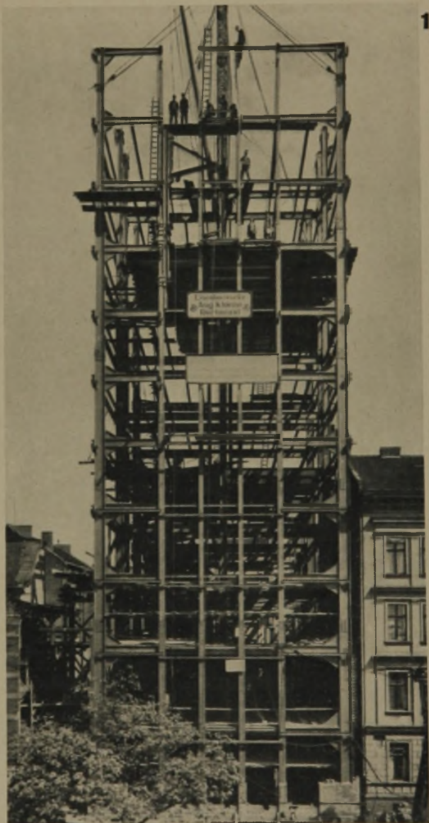
Montage des Stahlskelettes
