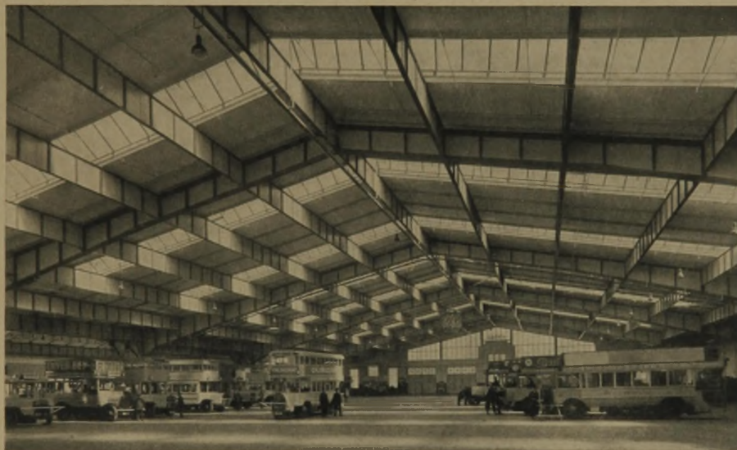
Betriebshof Helmholtzstraße. Wagenhalle. Spannweite 53,5 + 18,6 m. Binder mit vollwandigen Blechträgern. Zugband unter dem Fußboden. ARCH. BAURAT FRANZ AHRENS, BERLIN
