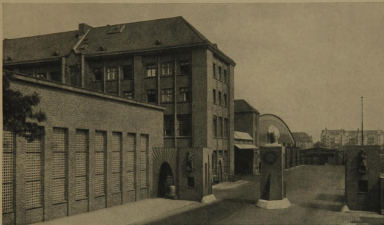
Einfahrt in den Betriebshof Treptow
