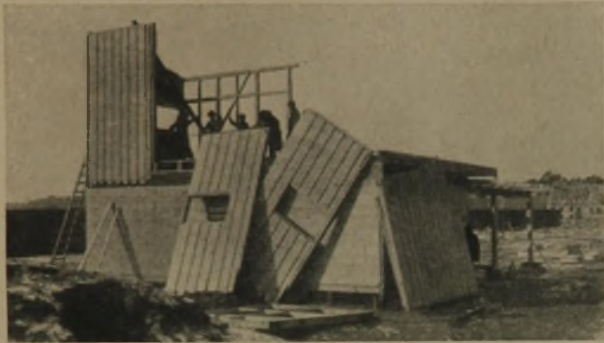
Dgl. Am 2. Tag der Bauausführung
