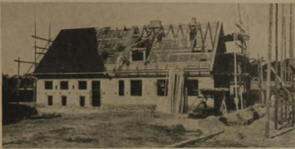
Halbbauernstelle. Arch. Klement, Potsdam Mauerwerk aus Bimsbetonsteinen, Dach mit Durasbest gedeckt
