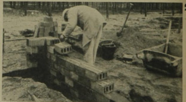
Bauernstelle. Arch. Klement, Potsdam Mauern mit Frewen-Ziegeln
