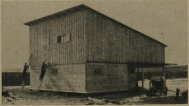
Dgl. Am 3. Tag der Bauausführung
