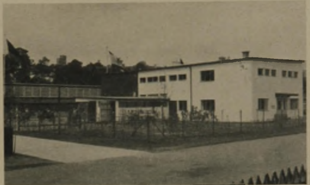
Dgl. wie 14. Fertige Anlage
