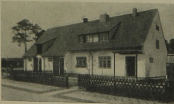
Bauernstelle. Arch. Klement, Potsdam Frewen-Ziegel geputzt, Dach Durasbestplatten
