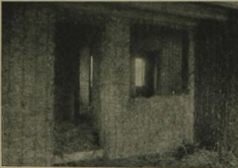
Obstgärtnerstelle. Arch. Klaus Engler Holzskelett mit Solomitverkleidung
