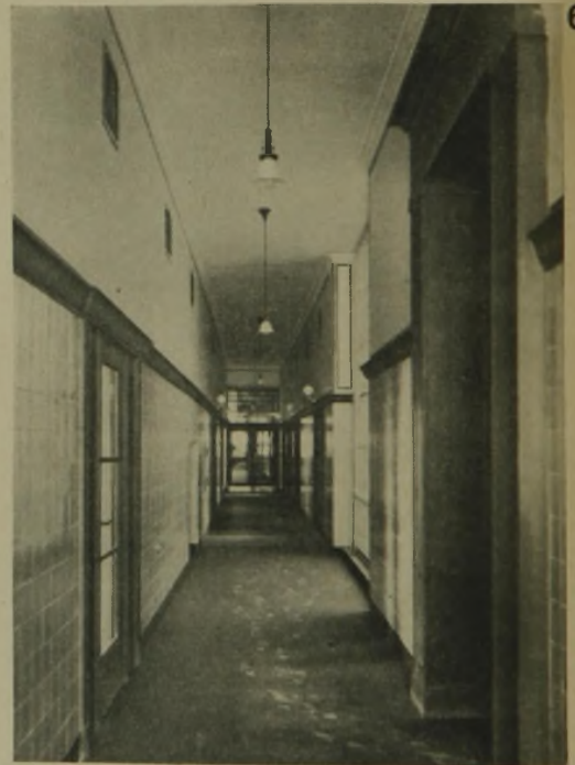
6 Anordnung von Holz-Profil- leisten, hinter denen die Leitungen verlegt werden
