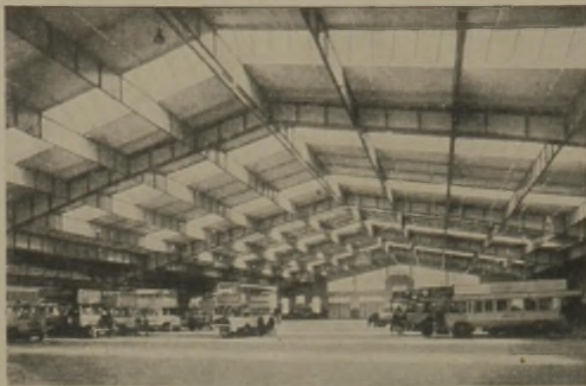
Autogarage der Aboag in Berlin mit Sprinkler-Anlagen
