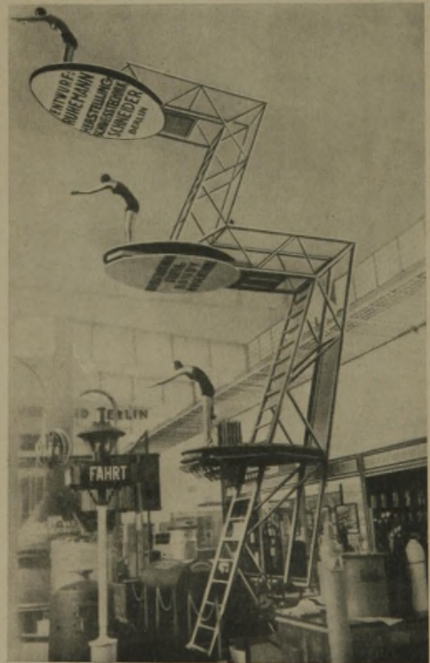
Aus Rohren geschweißter Sprungturm von rd. 10 m Höhe Ausführung: Schweißtechnik Schneider, Berlin
