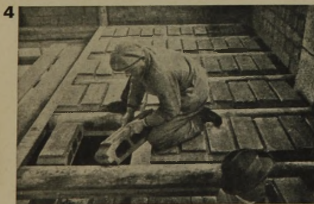
Verlegen der Hohlkörper
