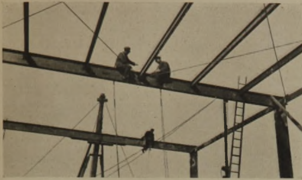
Landwirtschaftliche Halle Gasschweißer bei der Arbeit Ausführung Carbid-Vereinigung Foto Taubert-Neumann, Berlin
