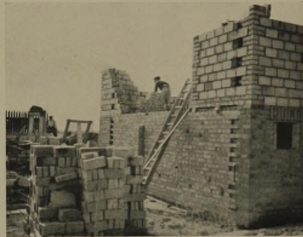
Wand aus No-Fo-T-Ziegeln
