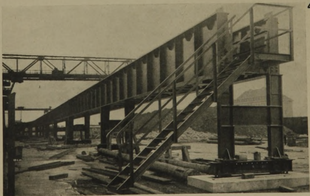
Absturzbrücke der Städt. Gaswerke Neukölln (Geschweißte Stahlkonstruktion)
