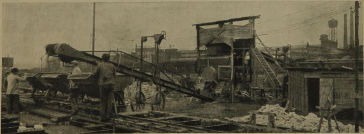
Mischmaschine „Contistat“ mit Förderbändern im vollen Betrieb
