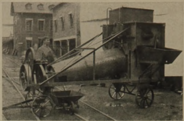
3 „Rohrdommel“ mit Abmeßvorrichtungen am Füllrichter, bestehend aus 3 Bechern für Kies, Sand, Zement
