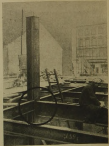
2 Aufgestellter Stahlrahmen ohne oberen Riegel
