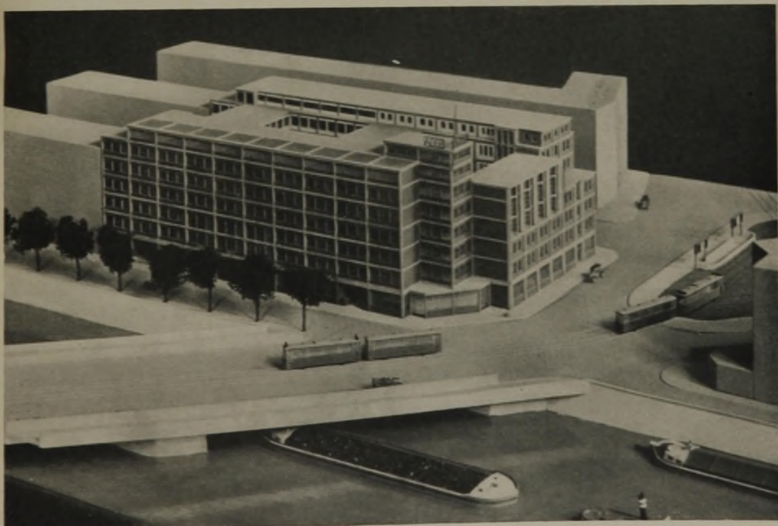
ABB. 1. MODELLAUFNAHME. BEWERTUNG AN 1. STELLE Verfasser: Architekt B. D. A. Max Taut, Berlin
