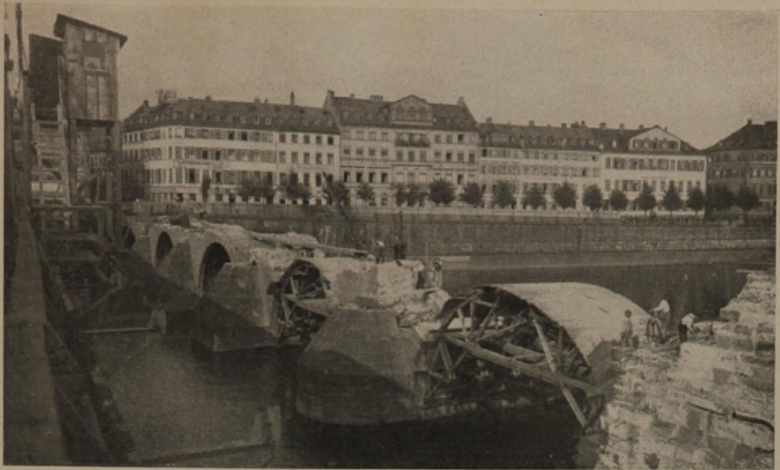
Abb. 7. Abbruch der alten Brücke. (Blick auf die Frankfurter Seite.)
