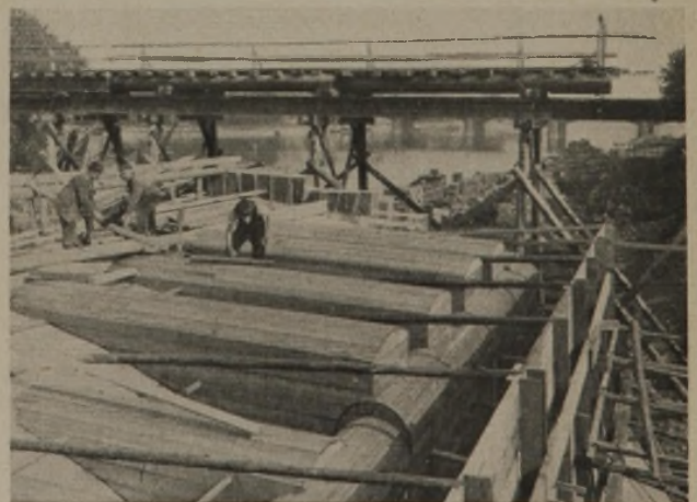
Abb. 10. Einschalung der Fahrbahnrippen. Die neue „Alte Brücke“ zu Frankfurt a. M.
