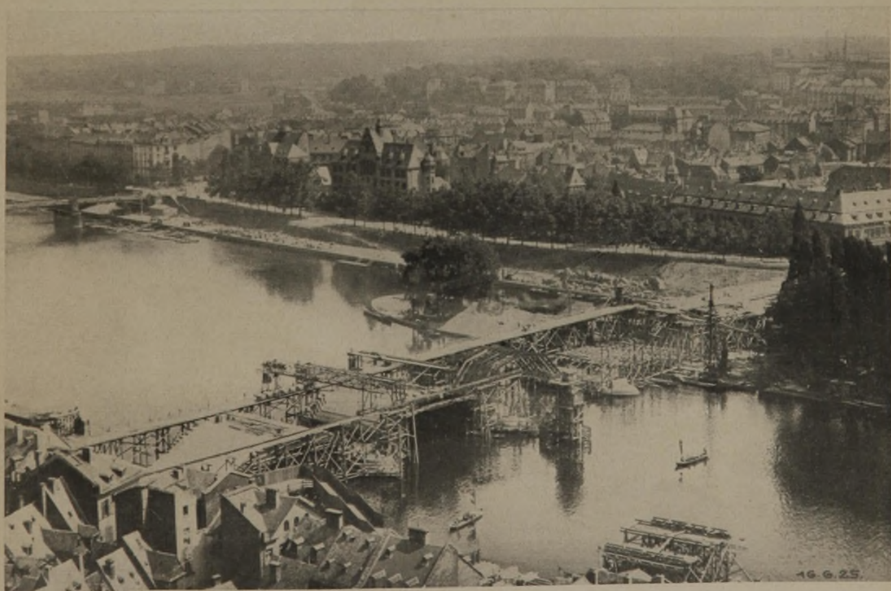
Abb. 1. Gesamtansicht der eingerüsteten neuen Brücke mit Blick auf Sachsenhausen.
