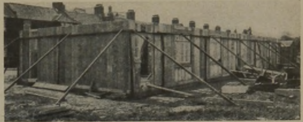
Abb. 1. Die Mauer aufgestellt bis Fußboden-Obergeschoß.
