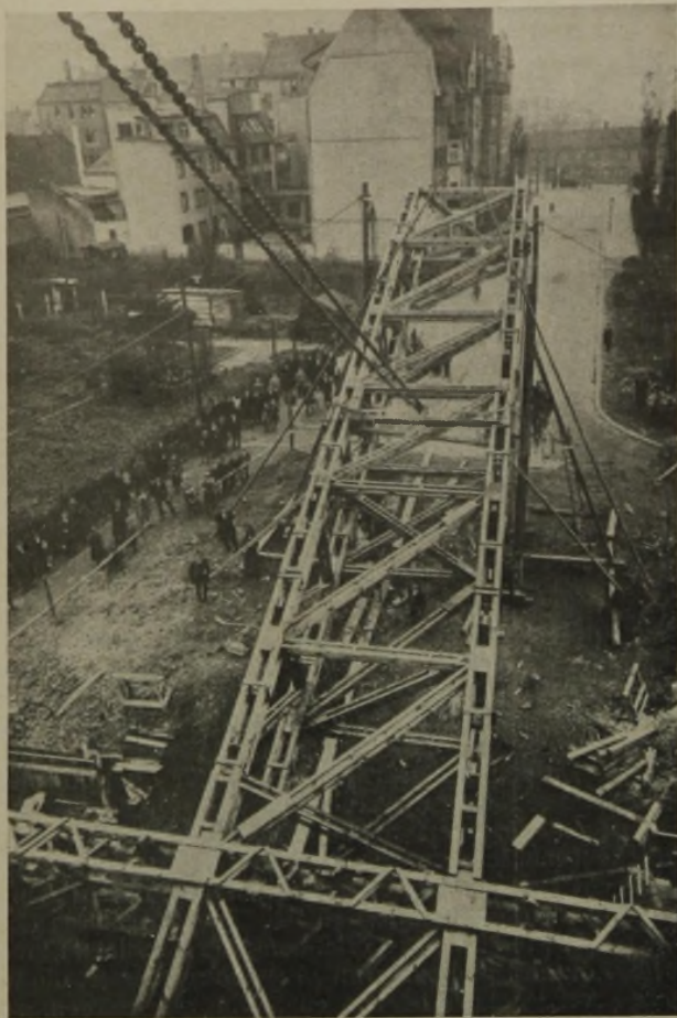
Abb. 2. Aufziehen des südlichen 30 m hohen Ständers. (Vom Gerüst aus gesehen.)
