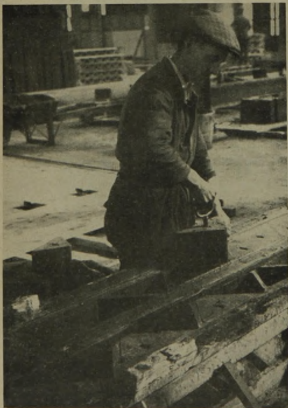
Abb. 11. Herausnehmen der Kernstücke der Balken.
