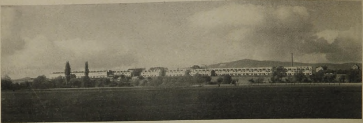
Abb. 2. Gesamtansicht der Siedlung Frankfurt a. M.-Praunheim.
