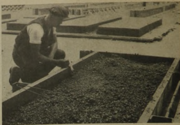
Abb. 12. Einlegen der Bewehrung i. d. Platten.
