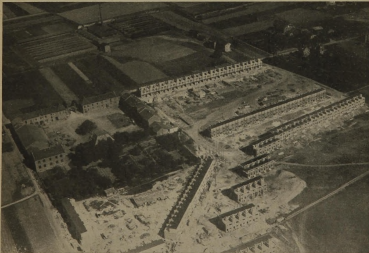
Abb. 1. Luftbild der Siedlung Frankfurt a. M.-Praunheim, während des Baus. (Dort sind die ersten Versuchsbauten erstellt.) (Aufnahmen der Südwest-Deutschen Luftverkehrs A. G.)
