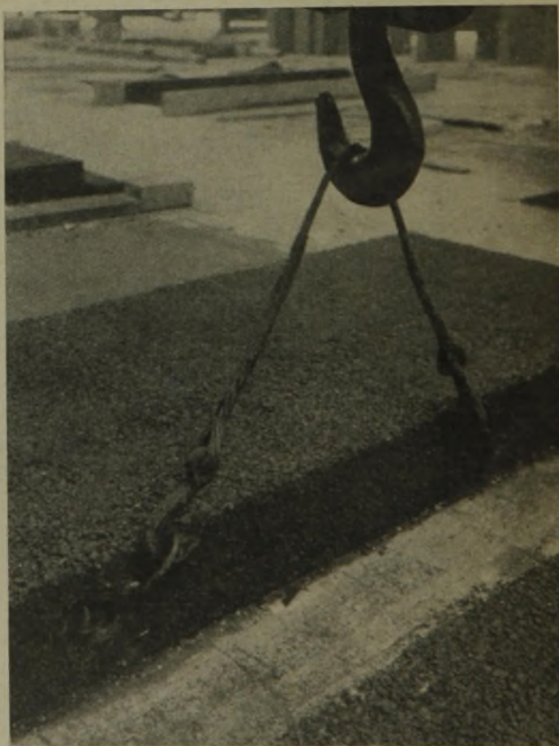
Abb. 14. Aufnehmen der fertigen Platten.
