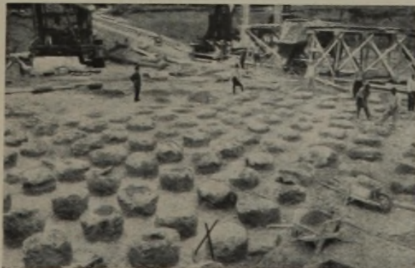
Abb. 4 (hierüber). Aufnahme der Baustelle zu Beginn der Gründungs- arbeiten.
