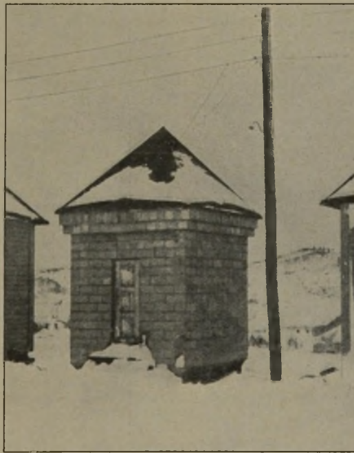
Abb. 5. Versuchshaus in Zellenbeton der Techn. Hochschule in Trondhjem.
