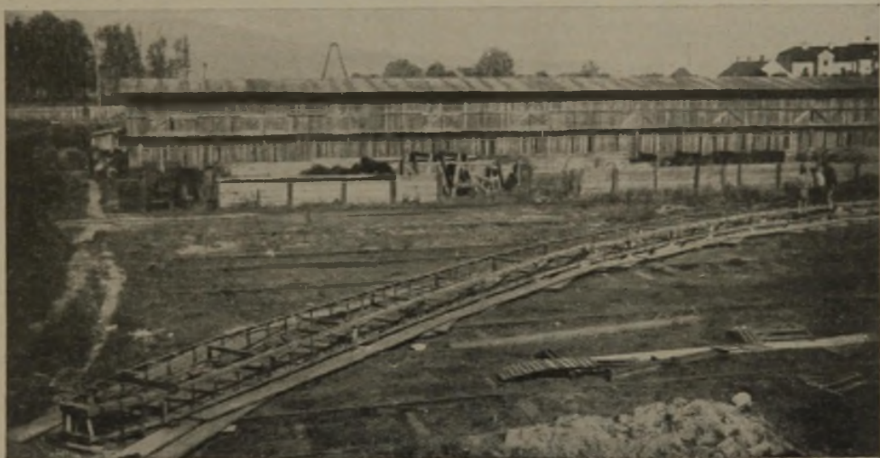
Abb. 22. Probemontage der Bewehrung im Fabrikhof.
