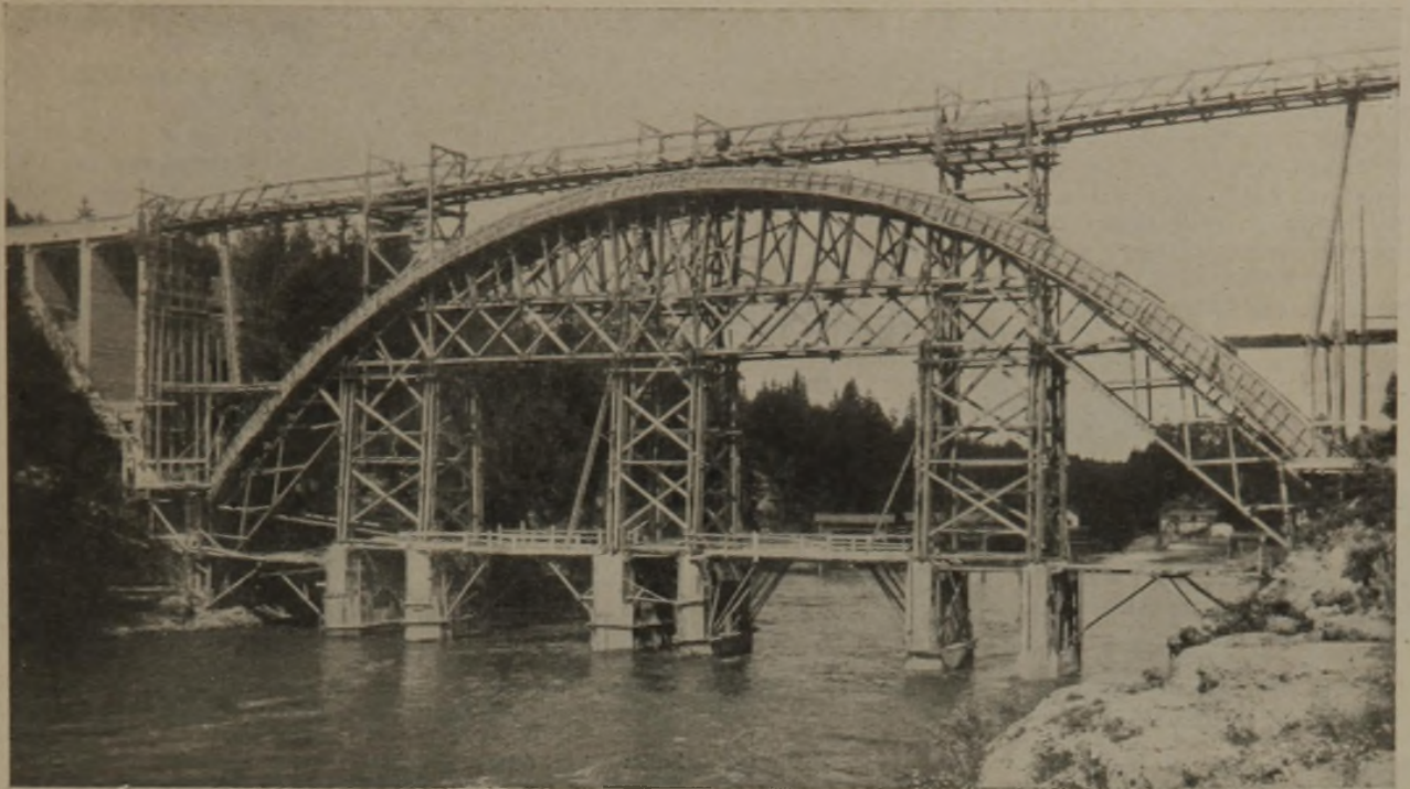
Abb. 21. Hölzernes Lehrgerüst der Traunfall-Brücke bei Gmunden. (Vgl. die Abb. 1, 2, 11, 12 und 13 in Nr. 7.)
